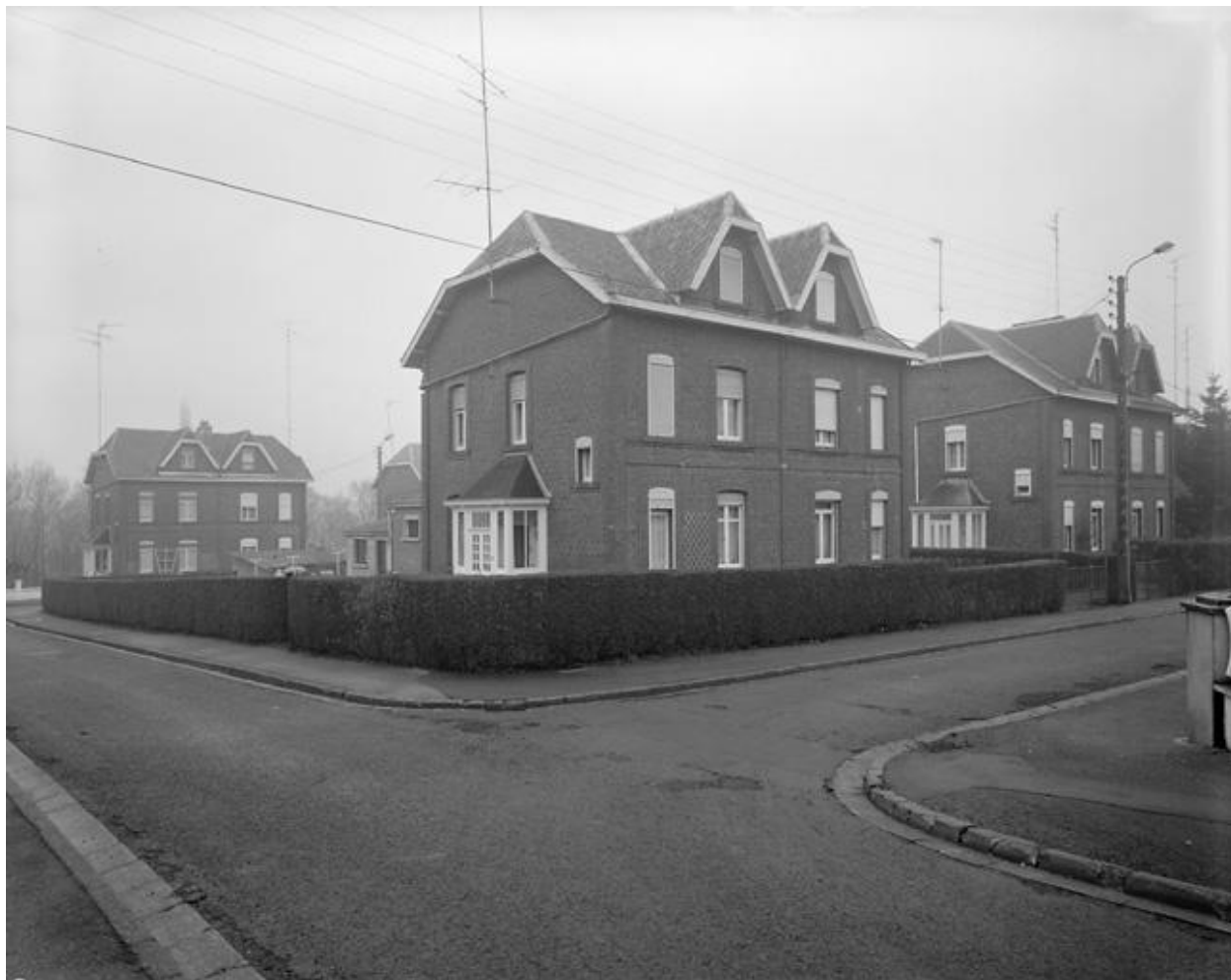
Vue générale de la Cité de la Vieille Montagne.
