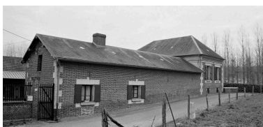
Maison d'habitation du moulin : façade sur rue. Phot. Bertrand Fournier IVR22_20006000100Z
