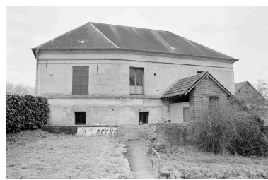
Atelier de fabrication doté de la cage de l'ancien moulin : façade postérieure. Phot. Bertrand Fournier IVR22_20006000109Z
