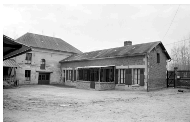
Maison d'habitation en brique et atelier de fabrication en retour construit en pierre : façades sur cour. Phot. Bertrand Fournier IVR22_20006000105Z
