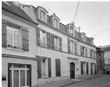
Elévation sur la rue. Phot. Thierry Lefébure IVR22_19930201905V
