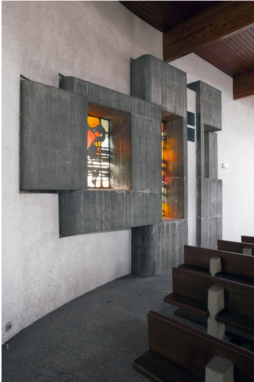
Vue intérieure de trois quart gauche des verrières sur le flanc gauche.
