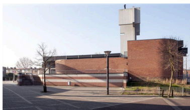
Vue du flanc droit de l'église et de la place. Phot. Pierre Thibaut IVR31_20155900971NUCA
