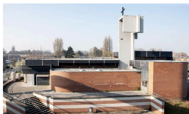
Vue du flanc droit de l'église. Phot. Pierre Thibaut IVR31_20155900969NUCA
