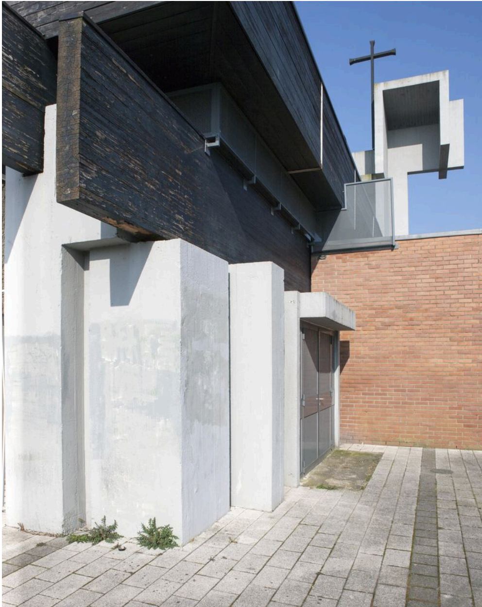
Vue de profil de l'entrée.
