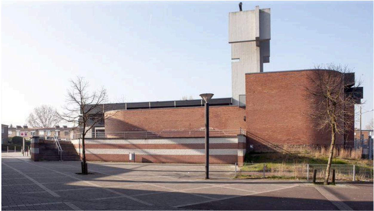
Vue du flanc droit de l'église et de la place.
