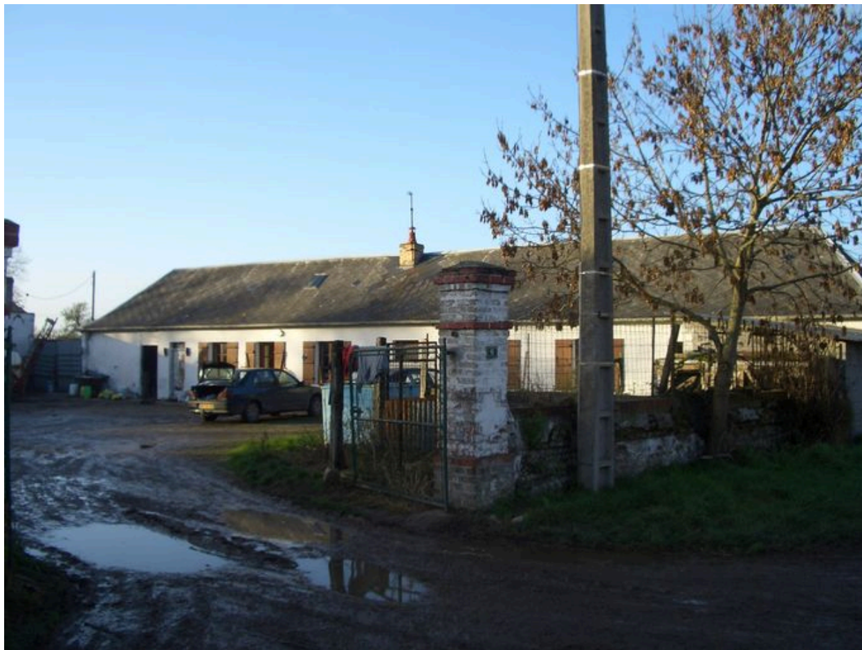
Vue du logis depuis la rue.
