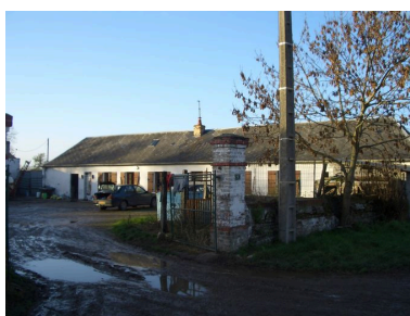
Vue du logis depuis la rue. Phot. Inès Guérin IVR22_20078005025NUCA
