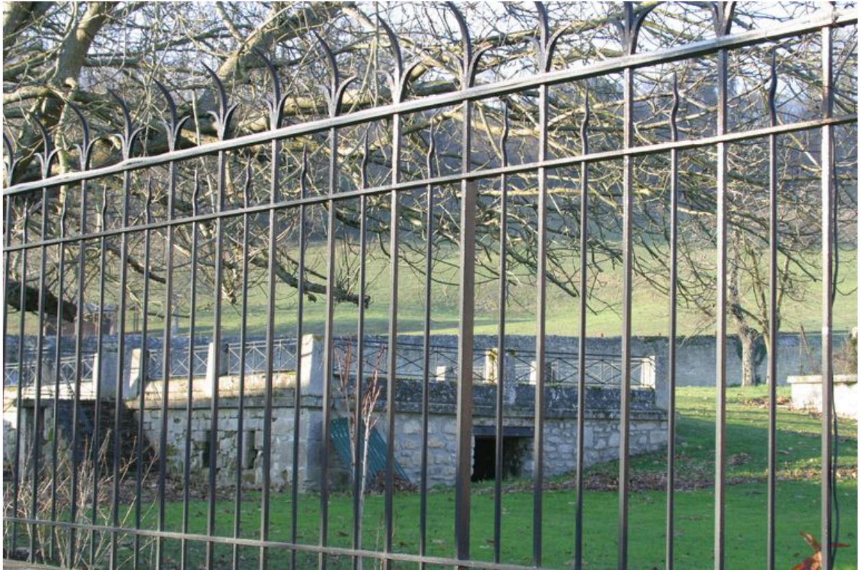
Vue de l'entrée des caves sous la terrasse.
