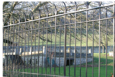
Vue de l'entrée des caves sous la terrasse. Phot. Inès Guérin IVR22_20030202704NUCA
