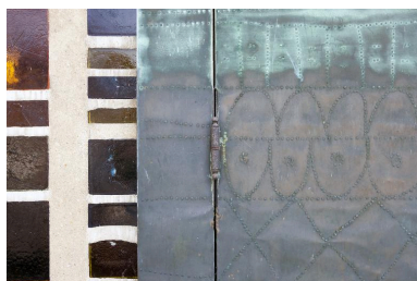
Détail du porche d'entrée. Phot. Pierre Thibaut IVR31_20155900138NUCA
