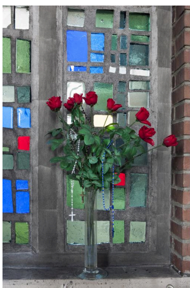
Détail d'une verrière côté gauche. Phot. Pierre Thibaut IVR31_20155900154NUCA
