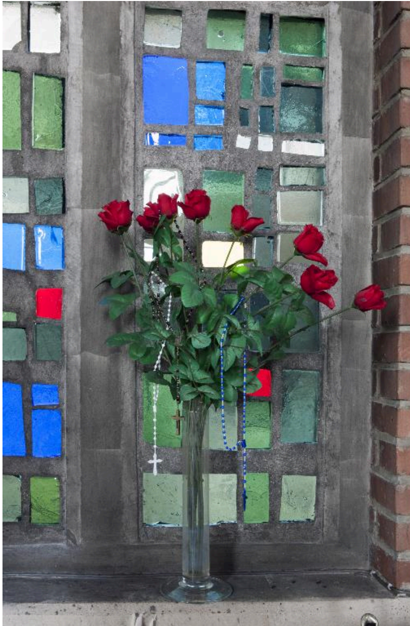
Détail d'une verrière côté gauche.
