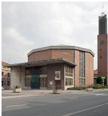
Vue générale élévation antérieure. Phot. Pierre Thibaut IVR31_20155900134NUCA
