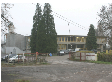
Façade de l'usine. Phot. Frédéric Pillet IVR22_20070205010NUCA
