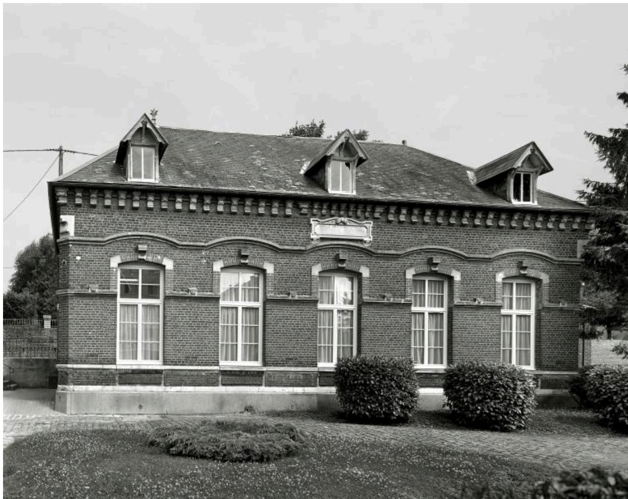
Vue du pavillon de la maternité, seul vestige de l'hôpital.
