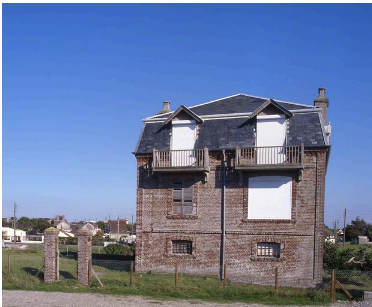
Elévation côté mer.
