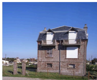
Élévation côté mer. Phot. Marie-Laure Monnehay-Vulliet IVR22_20048000145XA
