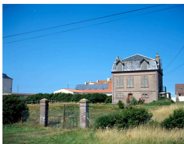
Élévation sur la rue Florent-Triquet. Phot. Marie-Laure Monnehay-Vulliet IVR22_20038000683XA
