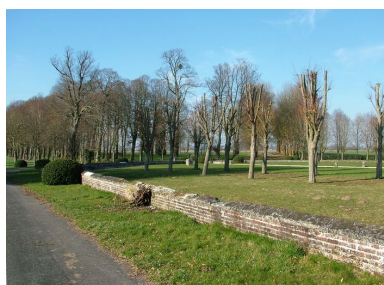
L'avenue de tilleuls et l'avenue de platanes axées sur la cour. Phot. Frédéric Fournis IVR22_20118001010NUCA
