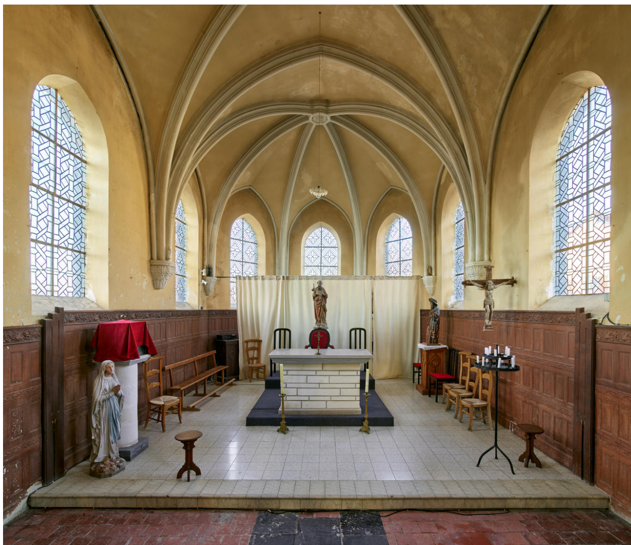
Vue générale du chœur.
