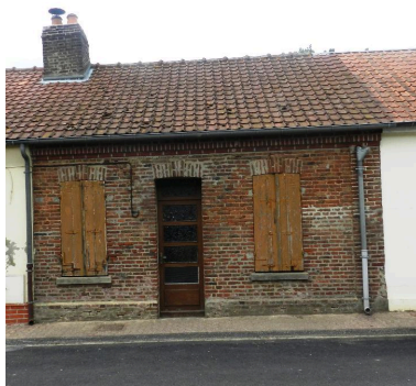
Façade d'un des logements. Phot. Romain Grimaud IVR22_20128015582NUCA
