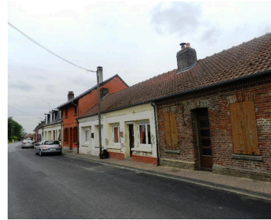
Vue générale, depuis l'est. Phot. Romain Grimaud IVR22_20128015583NUCA
