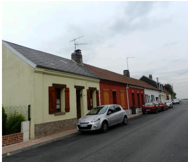
Vue générale, depuis le sud. Phot. Romain Grimaud IVR22_20128015581NUCA
