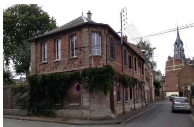
Bâtiment reconstruit à l'emplacement de l'ancienne salle de réception, construite en 1907 pour Charles Grosnier. Phot. Isabelle Barbedor IVR22_20158006123NUCA
