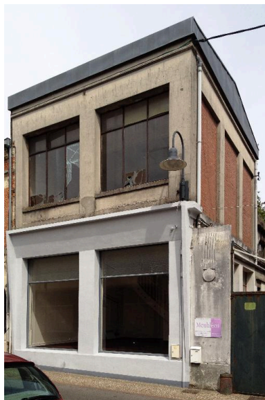
Vue des bureaux. Phot. Isabelle Barbedor IVR22_20158006204NUCA
