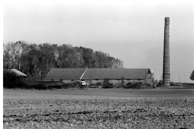
Four industriel et cheminée d'usine, vue flanc ouest. Phot. Benoît Dufournier IVR22_19878000195Z
