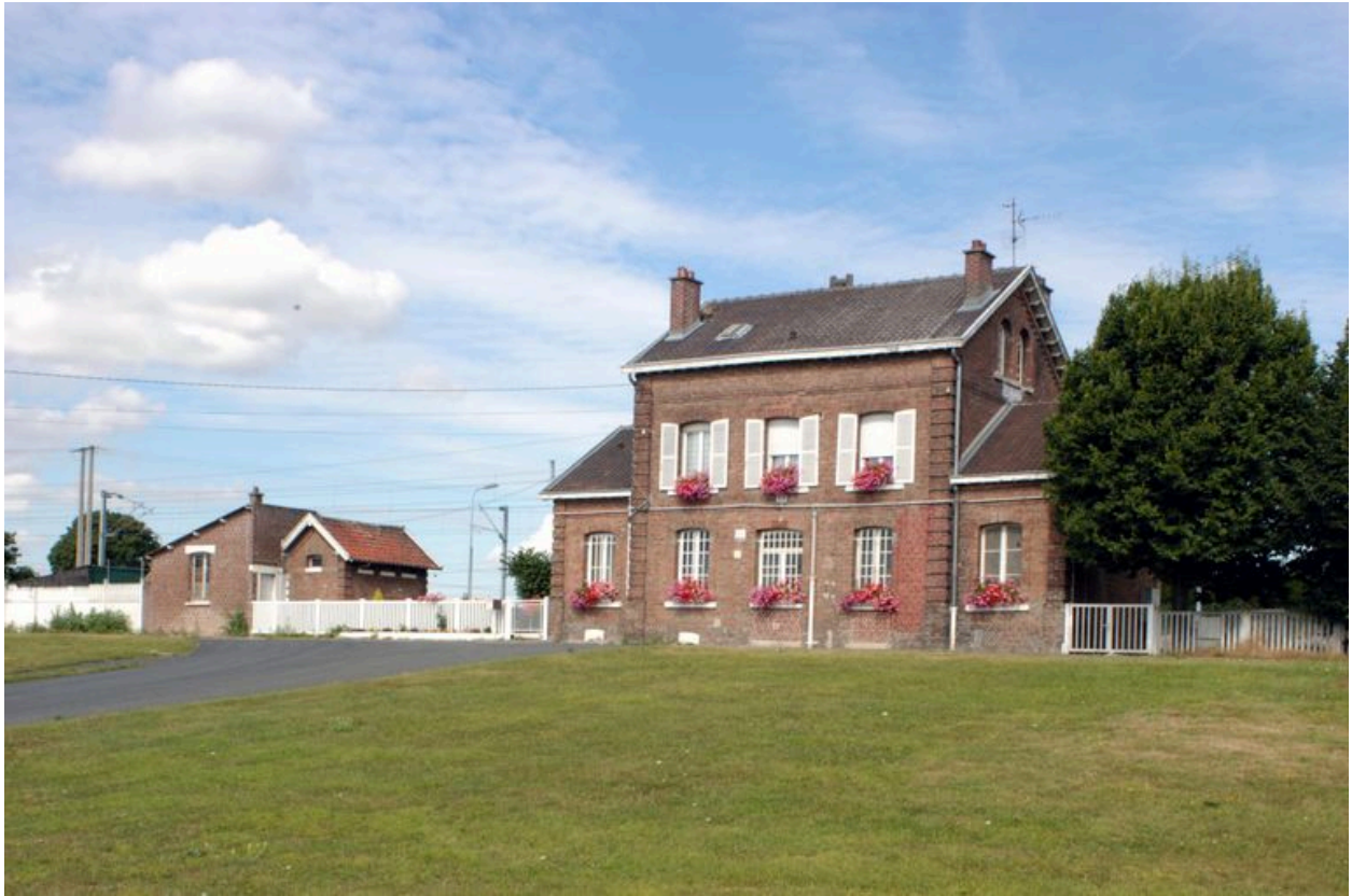
Vue de la façade est.
