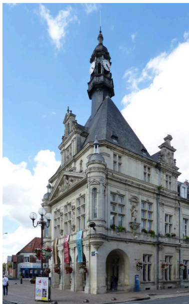
Le pavillon sud. Phot. Isabelle Barbedor IVR32_20178005461NUCA
