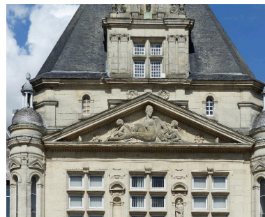
Vue de détail sur le fronton. Phot. Isabelle Barbedor IVR32_20178005268NUCA
