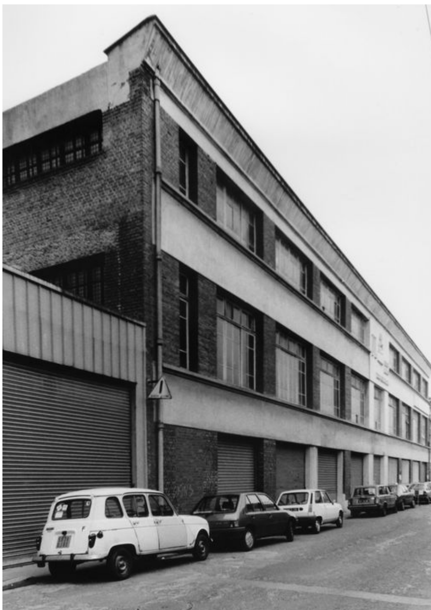
Magasin industriel, vue depuis le nord-est.
