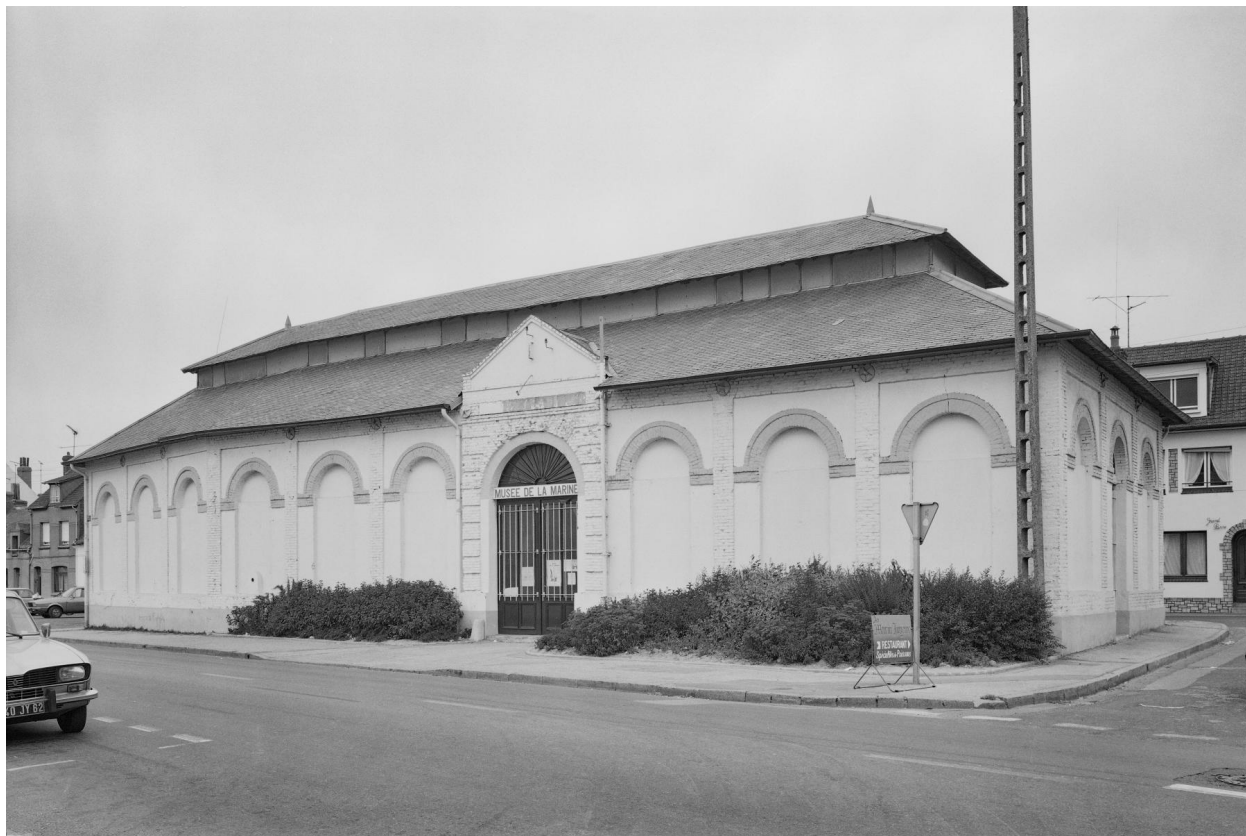
Vue générale de la halle à la criée depuis le boulevard.
