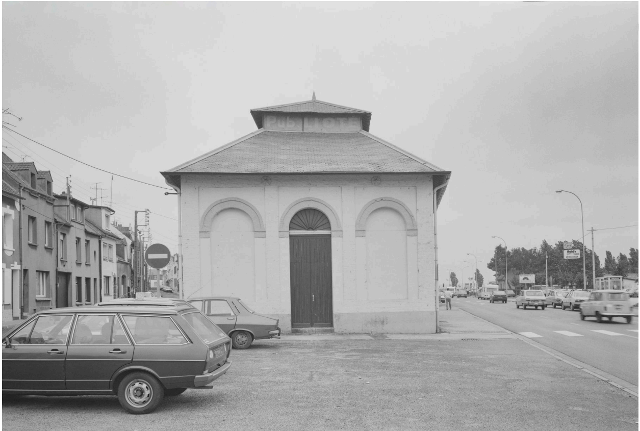
Vue latérale prise depuis le nord-ouest.
