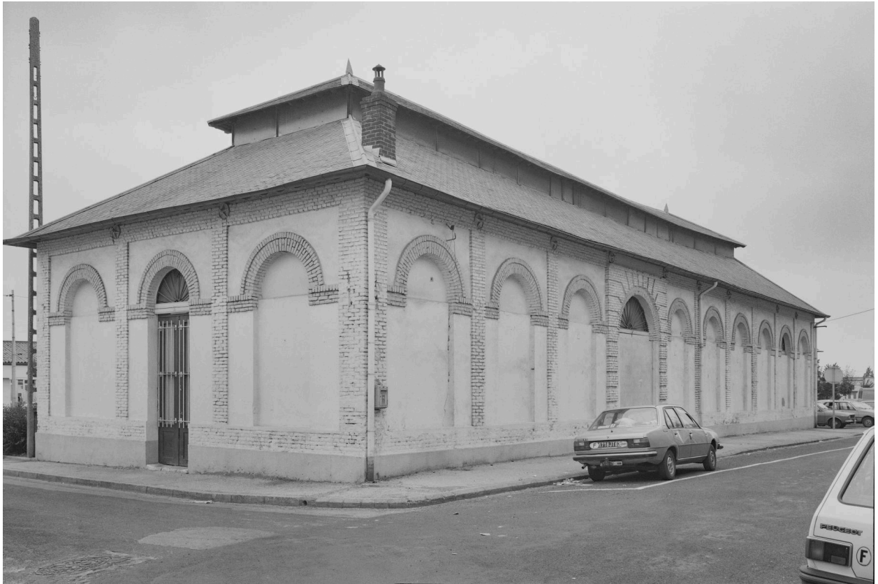
Vue de trois quarts de l'élévation postérieure prise depuis le sud-est (rue de Rosamel).
