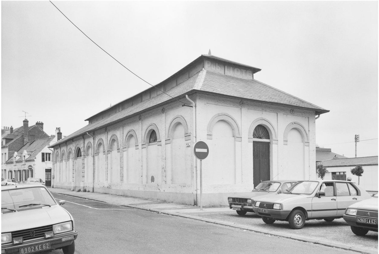
Vue de trois quarts de l'élévation postérieure prise depuis le nord-ouest.
