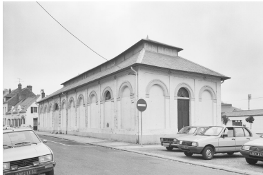
Vue de trois quarts de l'élévation postérieure prise depuis le nord-ouest. Phot. Philippe Caudroit IVR31_19836200261X
