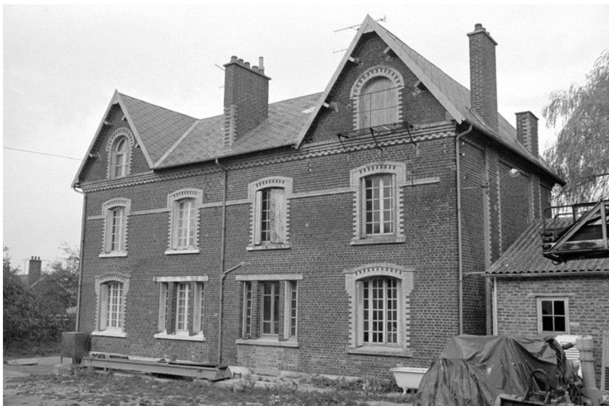
Logement patronal, élévation postérieure.
