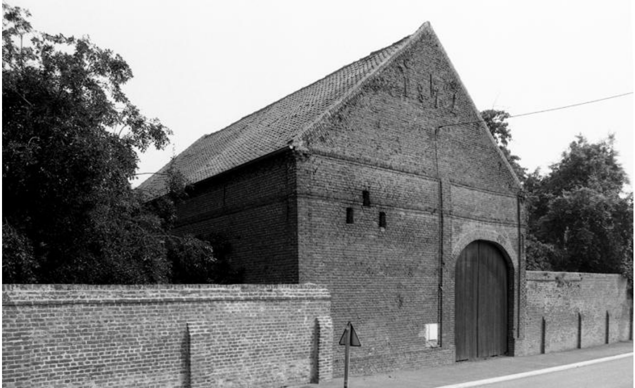
Vue de la grange, depuis le sud-ouest.
