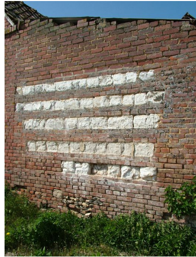
Détail de l'appareil du mur de clôture. Phot. Frédéric Fournis IVR22_20108001254NUCA
