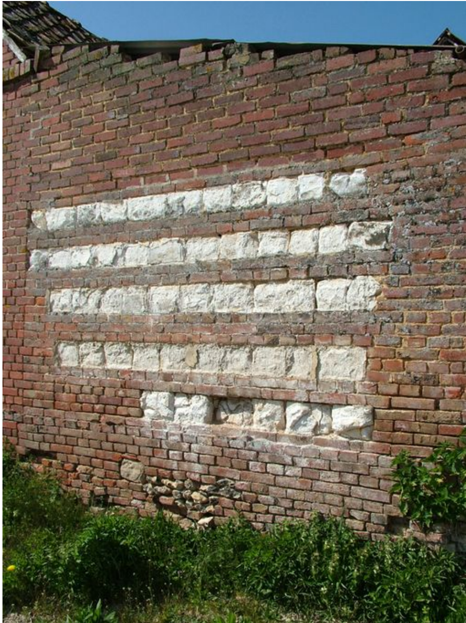
Détail de l'appareil du mur de clôture.
