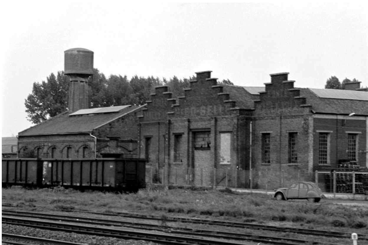
Elévation antérieure de l'atelier de fabrication.
