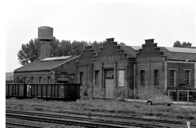
Elévation antérieure de l'atelier de fabrication.
