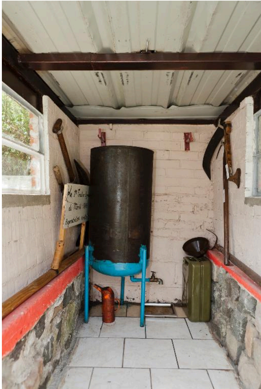
Abri de la locomobile, vue intérieure.
