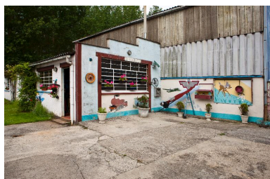
Vue générale de l'atelier. Phot. Hubert Bouvet IVR31_20145903039NUC4A
