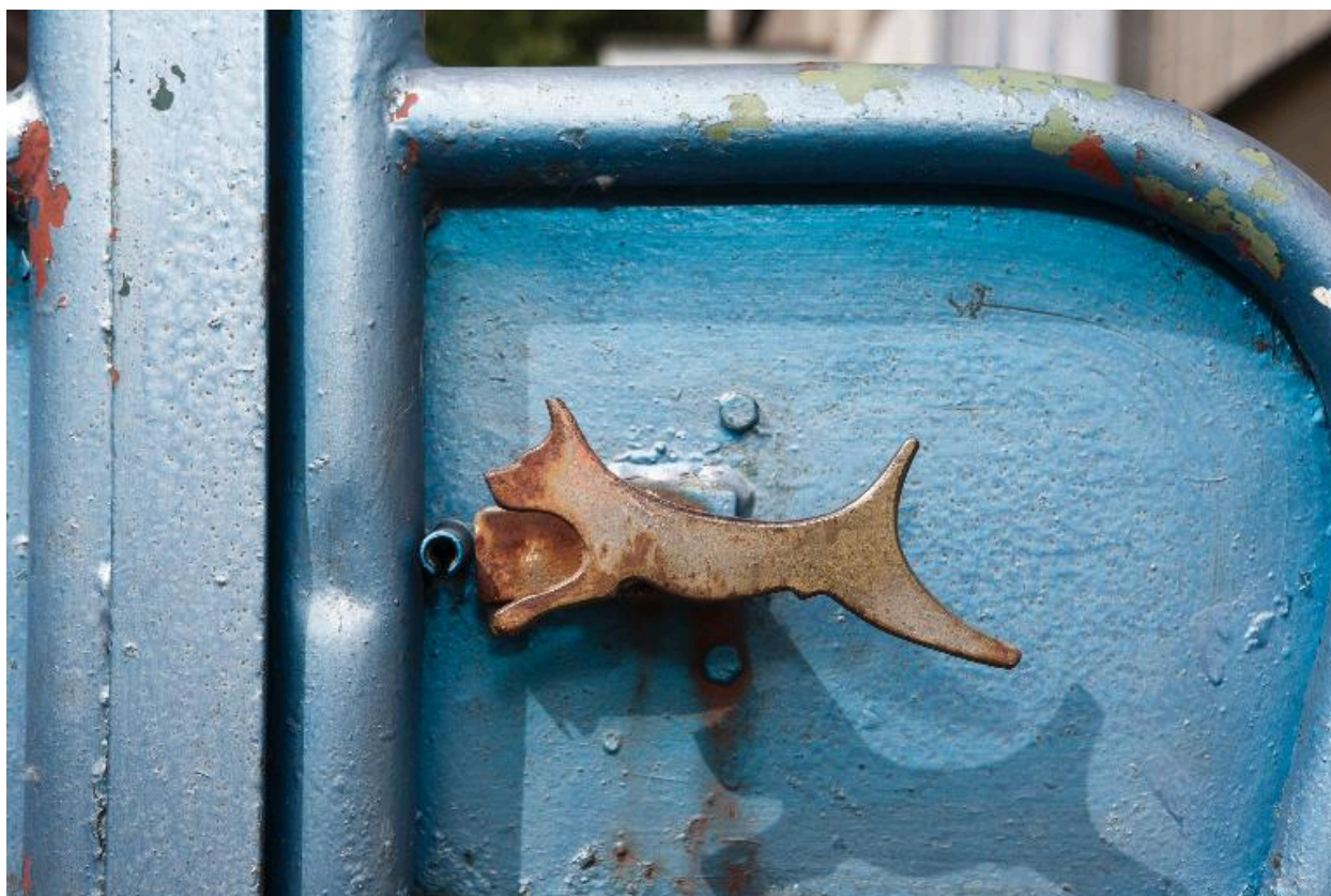
Portail d'entrée dans la cour : détail.
