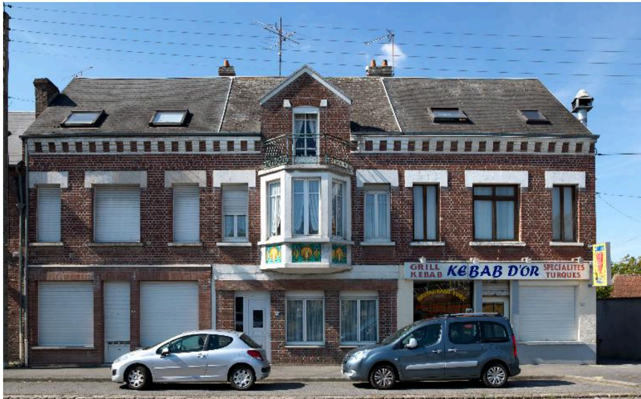
Maison, 34 à 38 rue de Noyon.
