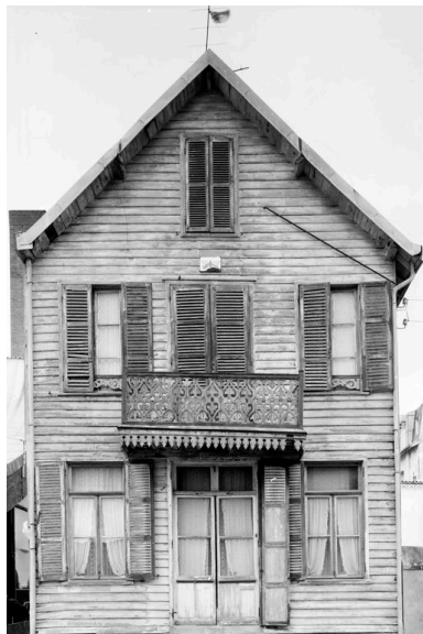
Vue générale de la facade en 1981. Phot. Philippe Caudroit IVR31_19816203671X
