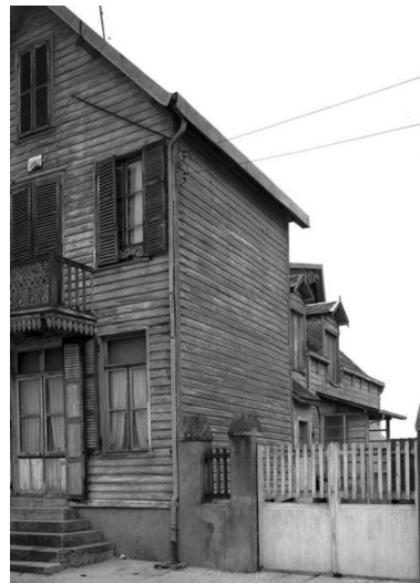
Façade latérale droite. Phot. Philippe Caudroit IVR31_19816203627X
