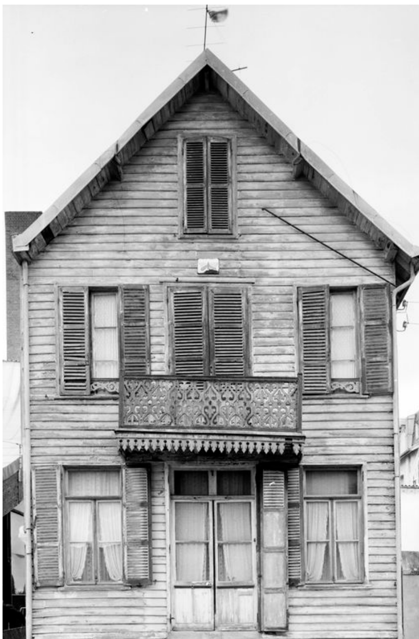
Vue générale de la facade en 1981.
