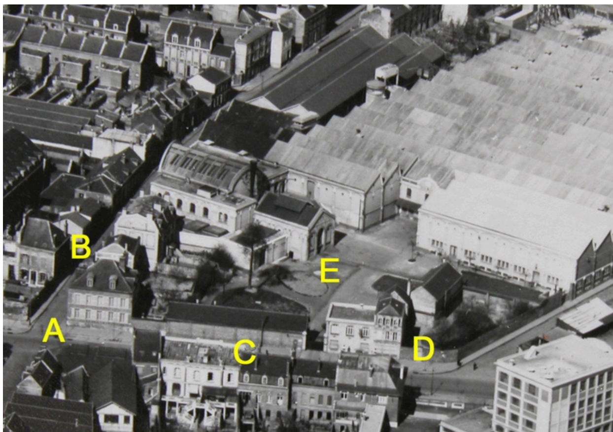
Le site dans les années 1930 : les logements patronal et de contremaître Hardempont (A et B), un hangar et le logement patronal du négoce de charbon (C et D), la chaufferie Touron à l'emplacement de la minoterie (E). (BM Saint-Quentin).
