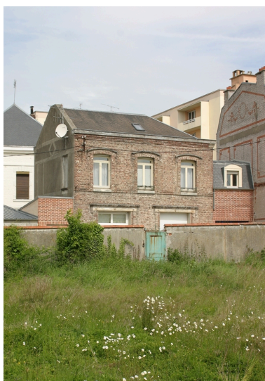
Ancien logement de contremaître : façade postérieure. Phot. Frédéric Pillet IVR22_20050205735NUCA
