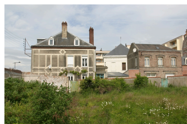
Façades postérieures des anciens logements de la minoterie Hardempont. Phot. Frédéric Pillet IVR22_20050205736NUCA
