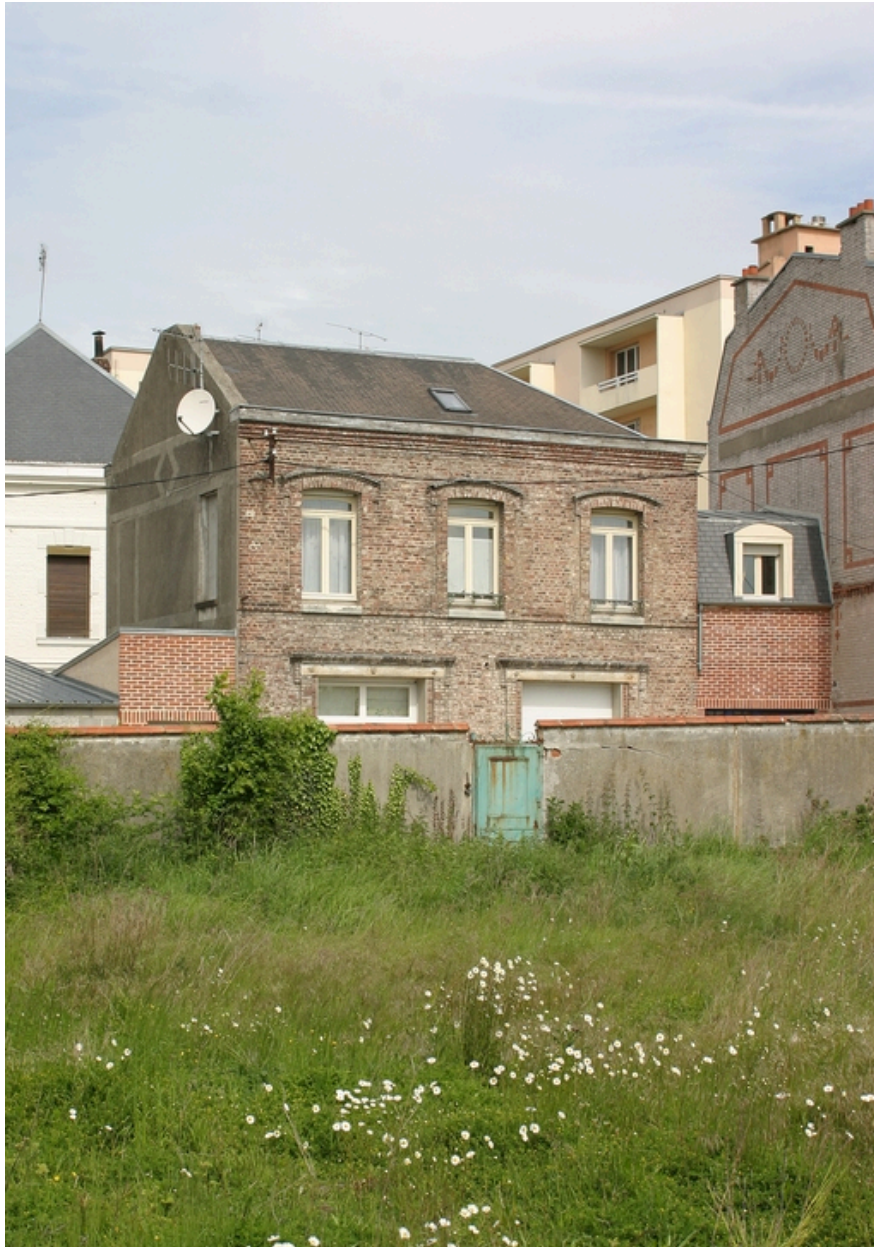
Ancien logement de contremaître : façade postérieure.
