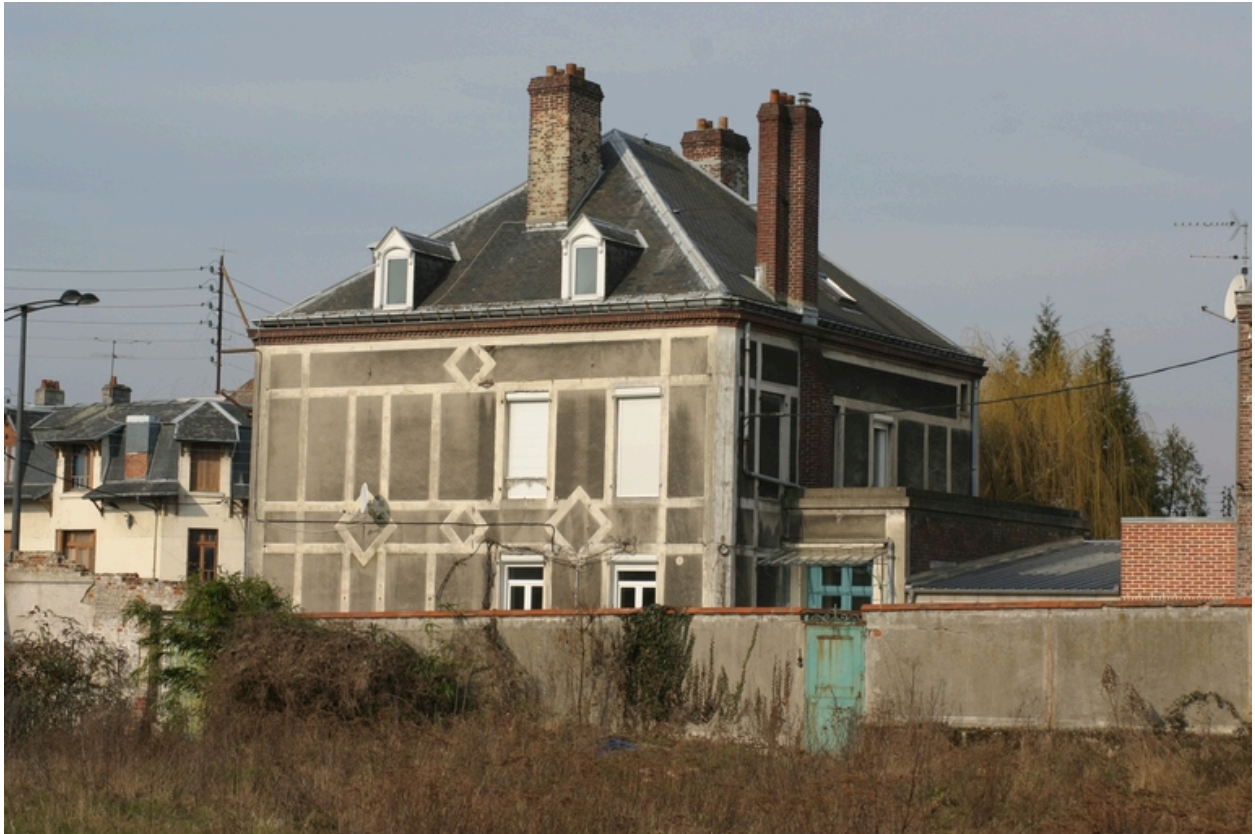
Ancien logement patronal de la minoterie vu depuis l'ancienne cour de la filature Touron.
