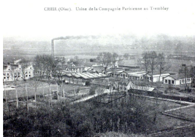
L'usine du Tremblay au début du 20e siècle (AC Creil).
