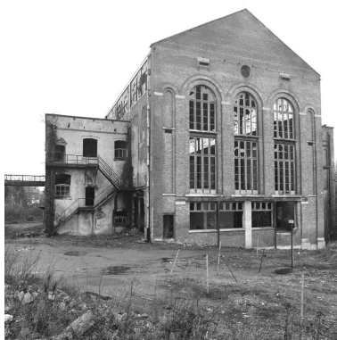
Vue générale de la centrale électrique de l'usine Vallourec en 1990 avant sa destruction. Phot. Olivier Marlard IVR31_19905900066X
