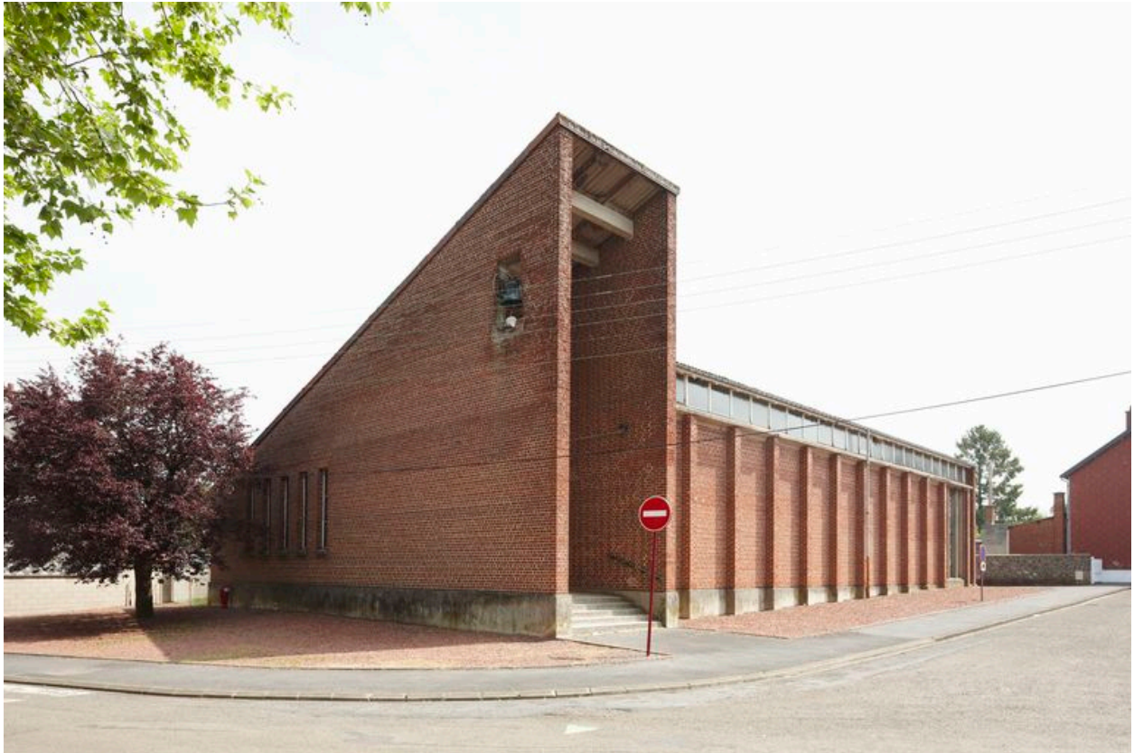
Église paroissiale Saint-Éloi, construite en 1961.
