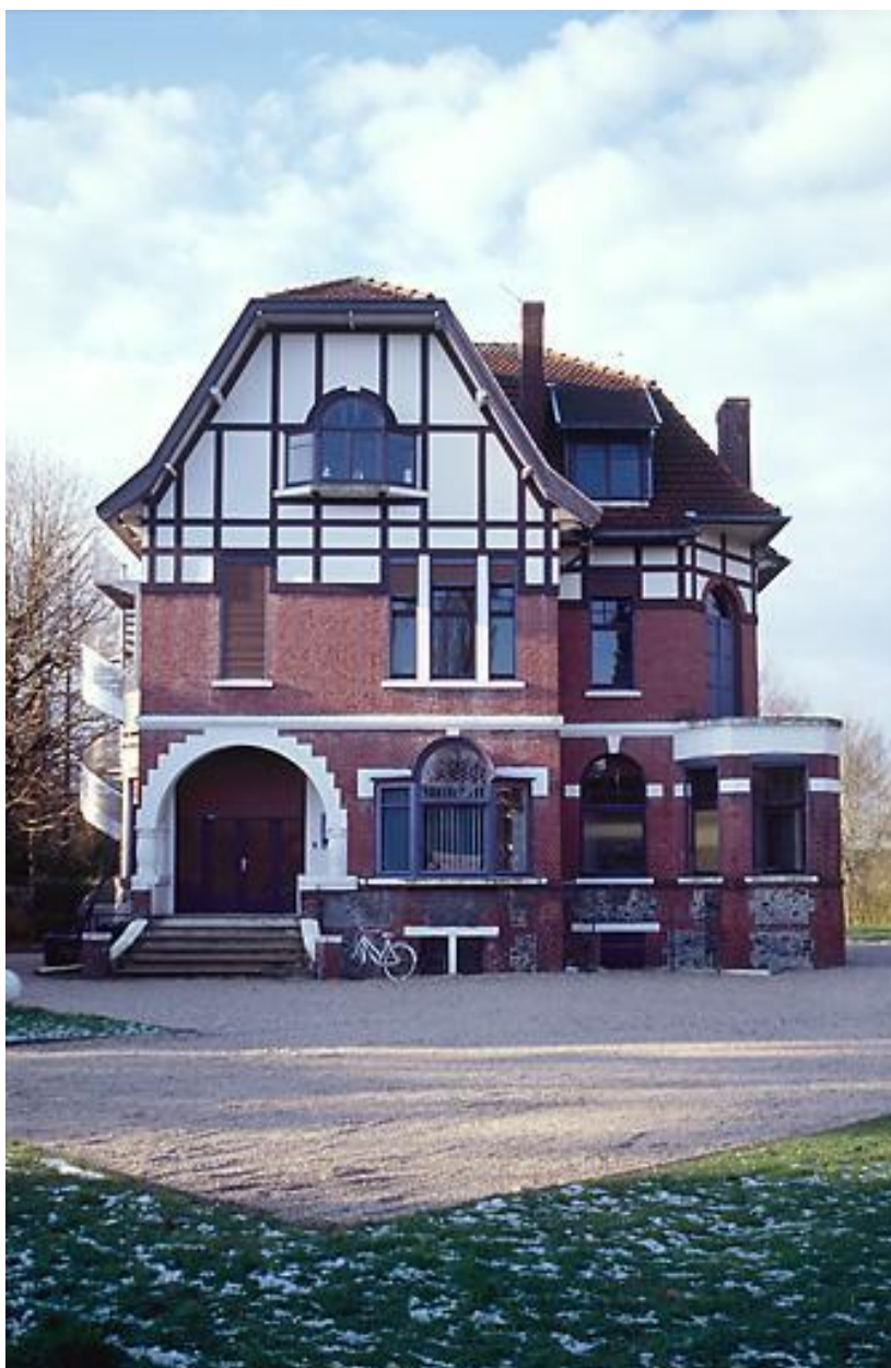
Maison sise au n°203 de la rue de l'Hôtel-de-ville, construite par Marcel Melon en 1927.
