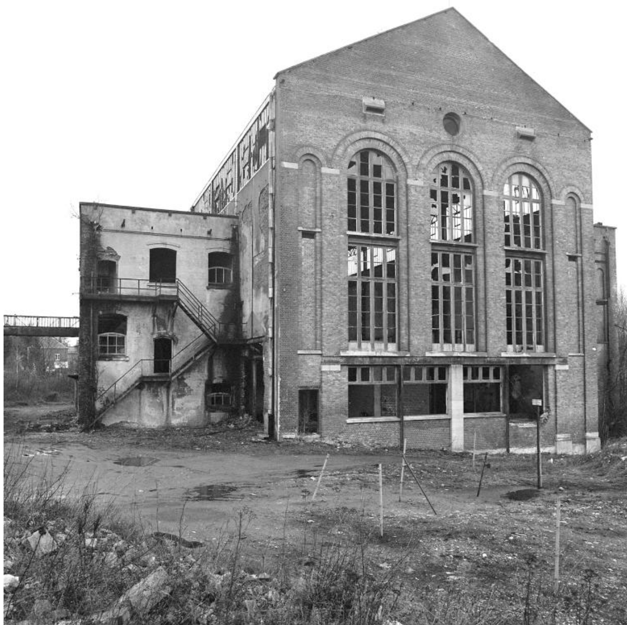
Vue générale de la centrale électrique de l'usine Vallourec en 1990 avant sa destruction.
