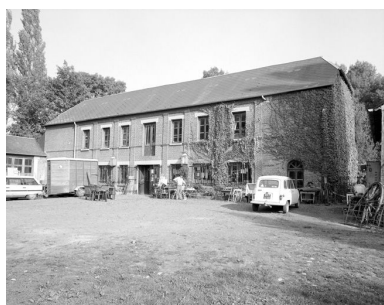
Atelier de fabrication, élévation antérieure. Phot. Thierry Lefébure IVR22_19898000414X
