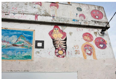
Façade, détail. Phot. Hubert Bouvet IVR31_20146203166NUC4A
