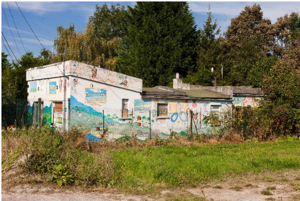
Vue de trois quarts depuis la rue.
