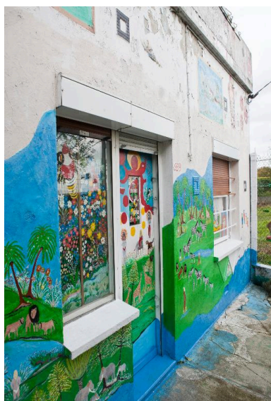
Façade sur rue. Phot. Hubert Bouvet IVR31_20146203153NUC4A
