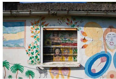
Mur gouttereau : détail avec une fenêtre. Phot. Hubert Bouvet IVR31_20146203147NUC4A
