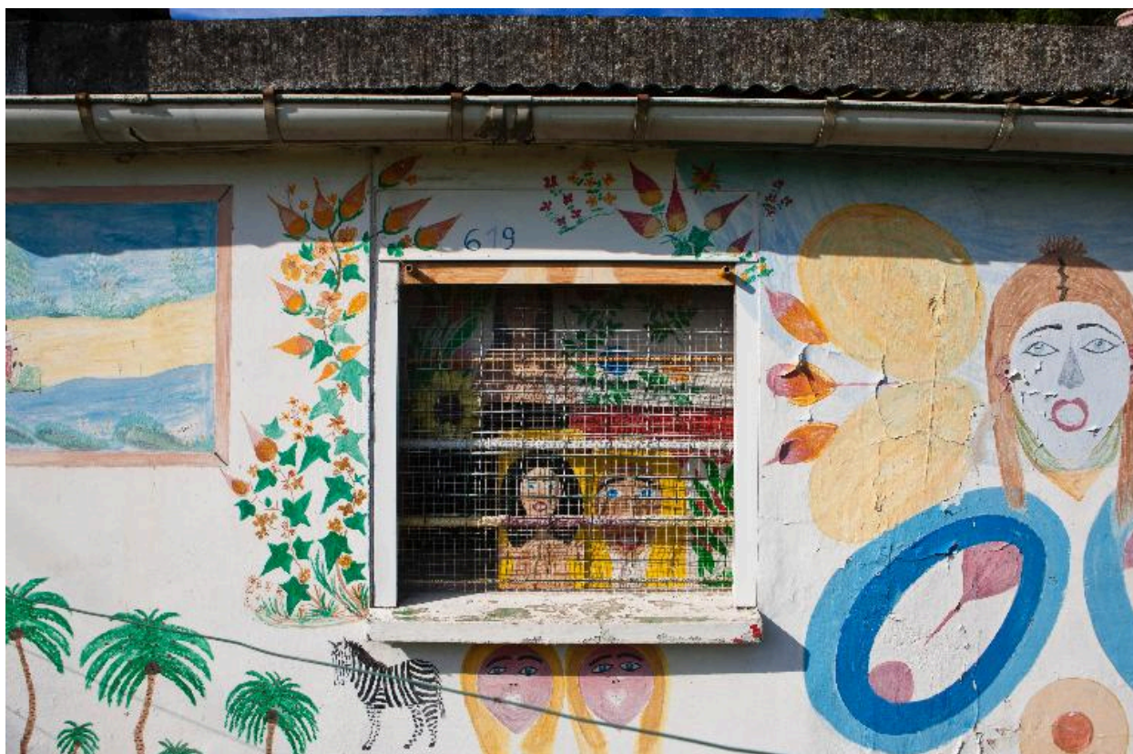
Mur gouttereau : détail avec une fenêtre.
