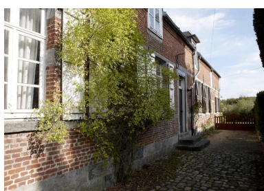
L'élévation sur cour du logis. Phot. Pierre Thibaut IVR31_20095903216NUCA
