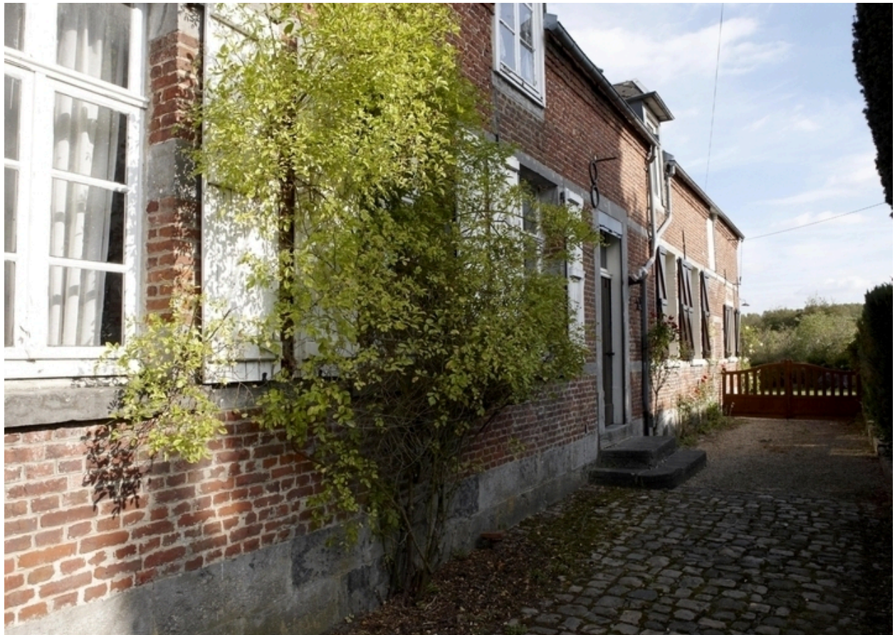
L'élévation sur cour du logis.
