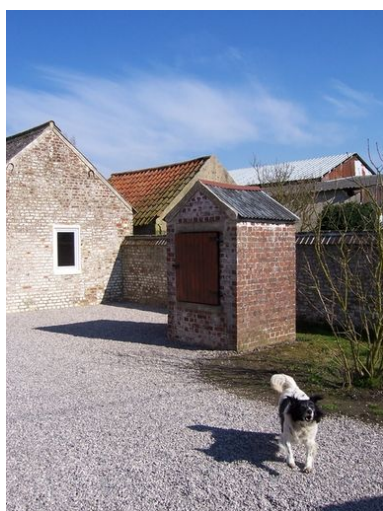
Vue générale du puits J. Phot. Cyril Cailleau IVR31_20045905423NUC
