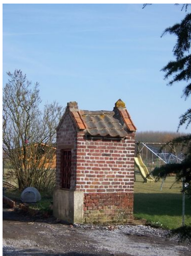
Vue générale du puits H. Phot. Cyril Cailleau IVR31_20045905421NUC
