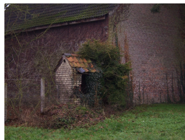
Vue générale du puits I. Phot. Cyril Cailleau IVR31_20045905422NUC
