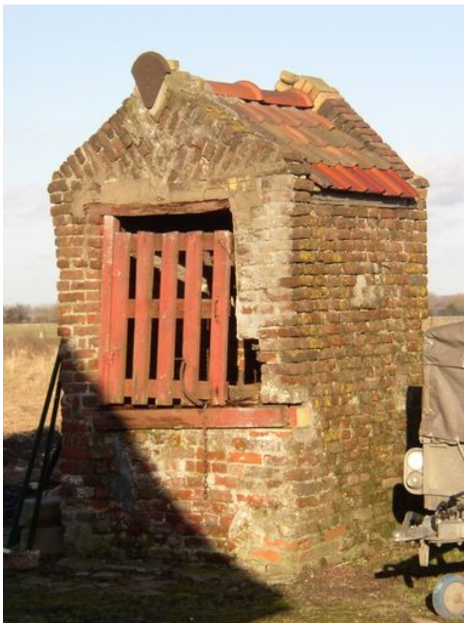
Vue générale du puits C.
