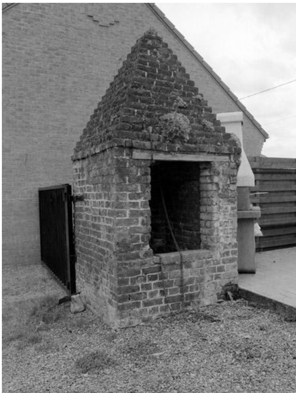
Vue générale du puits G.
