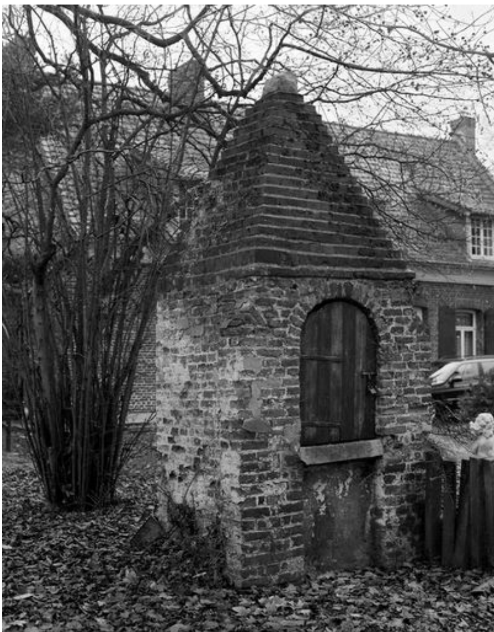
Vue générale du puits A.
