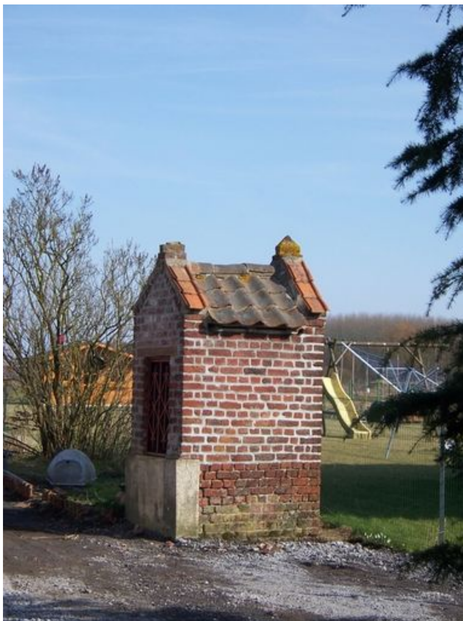
Vue générale du puits H.
