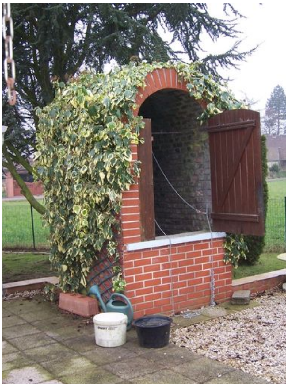
Vue générale du puits E.
