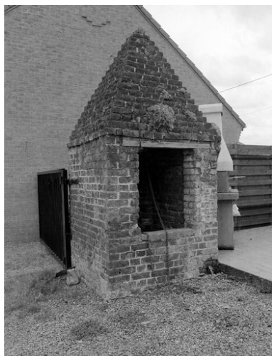
Vue générale du puits G. Phot. Philippe Dapvri IVR31_20045900444X
