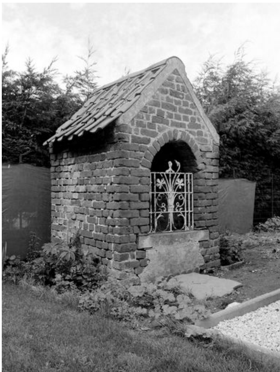
Vue générale du puits B.
