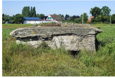
Vue générale vers l'ouest Phot. Jean-Marc Ramette IVR31_20145904503NUCA
