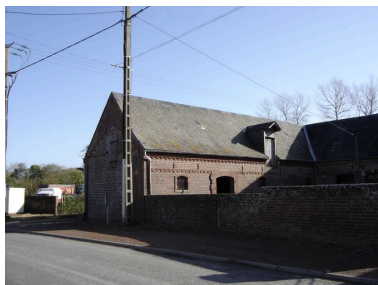
Vue des étables perpendiculaires au logis. Phot. Inès Guérin IVR22_20068005766NUCA
