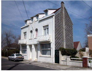
Vue d'ensemble, avec la façade latérale recouverte d'un essentage de matériau synthétique. Phot. Elisabeth Justome IVR22_20058002960NUCA
