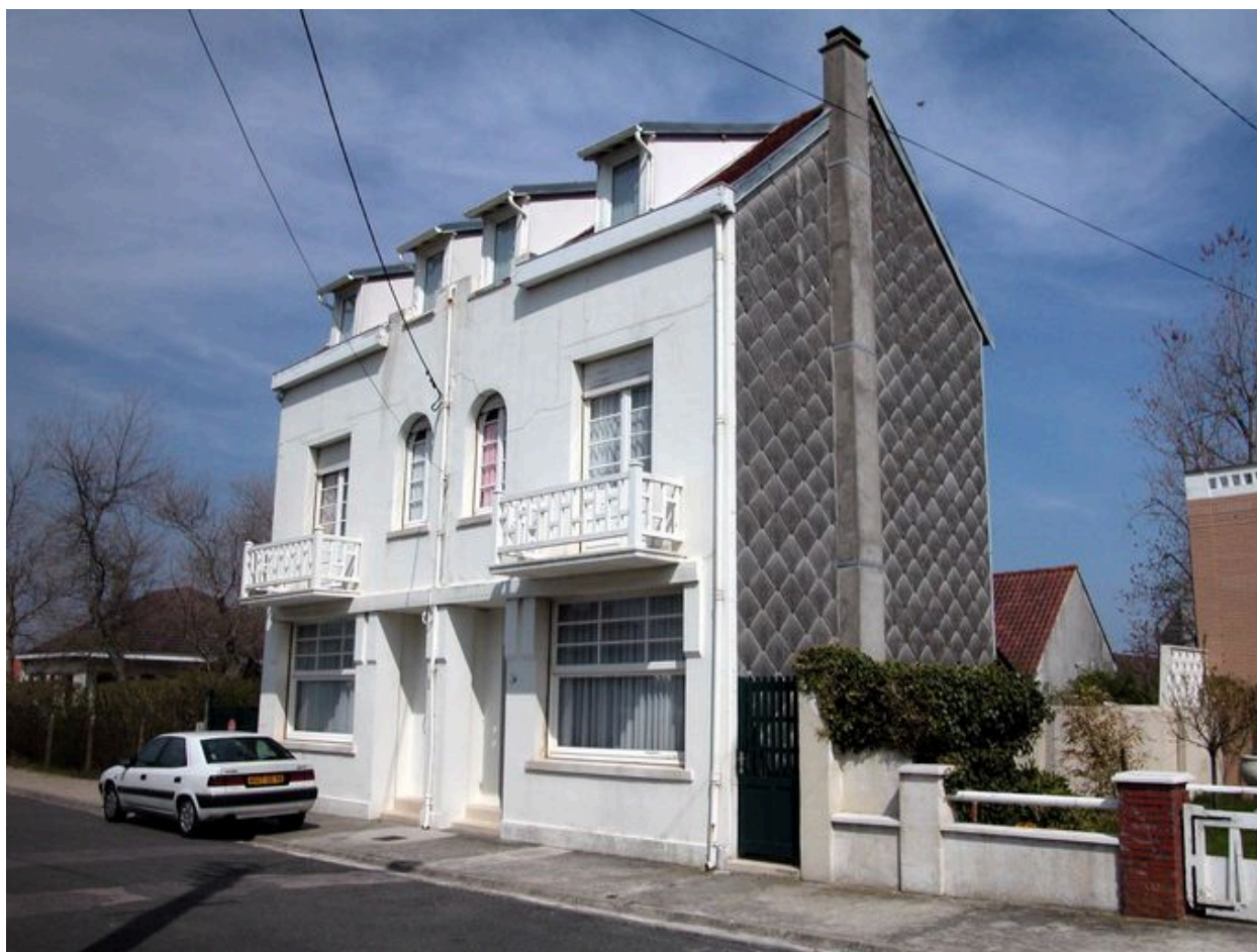
Vue d'ensemble, avec la façade latérale recouverte d'un essentage de matériau synthétique.
