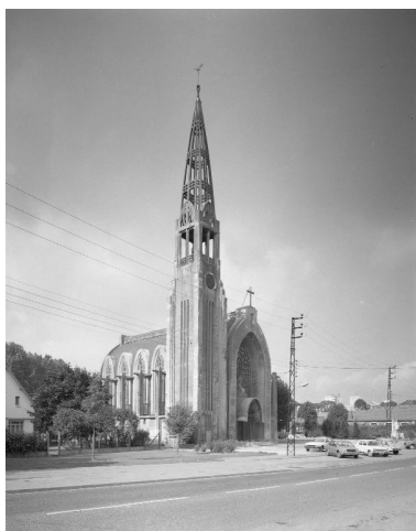
Vue générale prise du Nord Ouest. Phot. Philippe Caudroit IVR31_19806204360V
