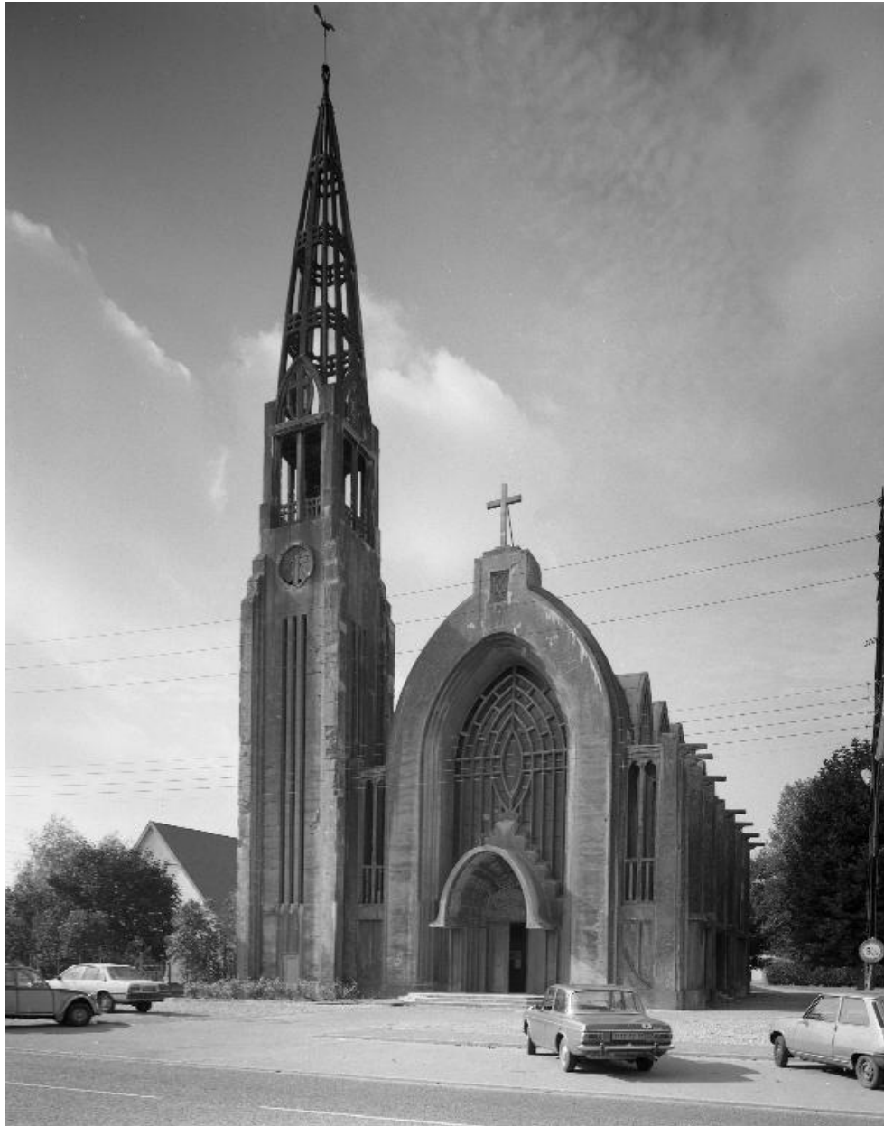
Vue générale prise du Nord Est.
