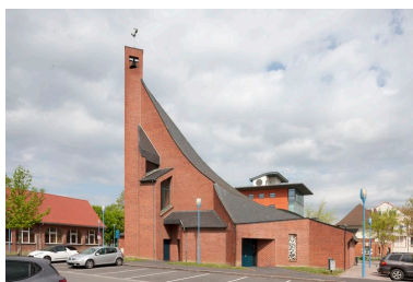
Vue générale prise du sud est. Phot. Hubert Bouvet IVR31_20156200160NUCA
