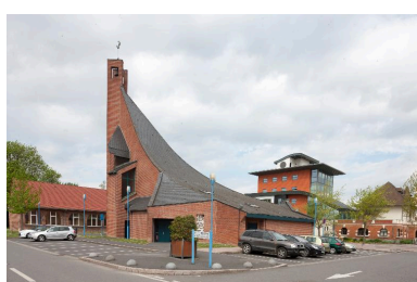
Vue générale prise du sud-est. Phot. Hubert Bouvet IVR31_20156200161NUCA
