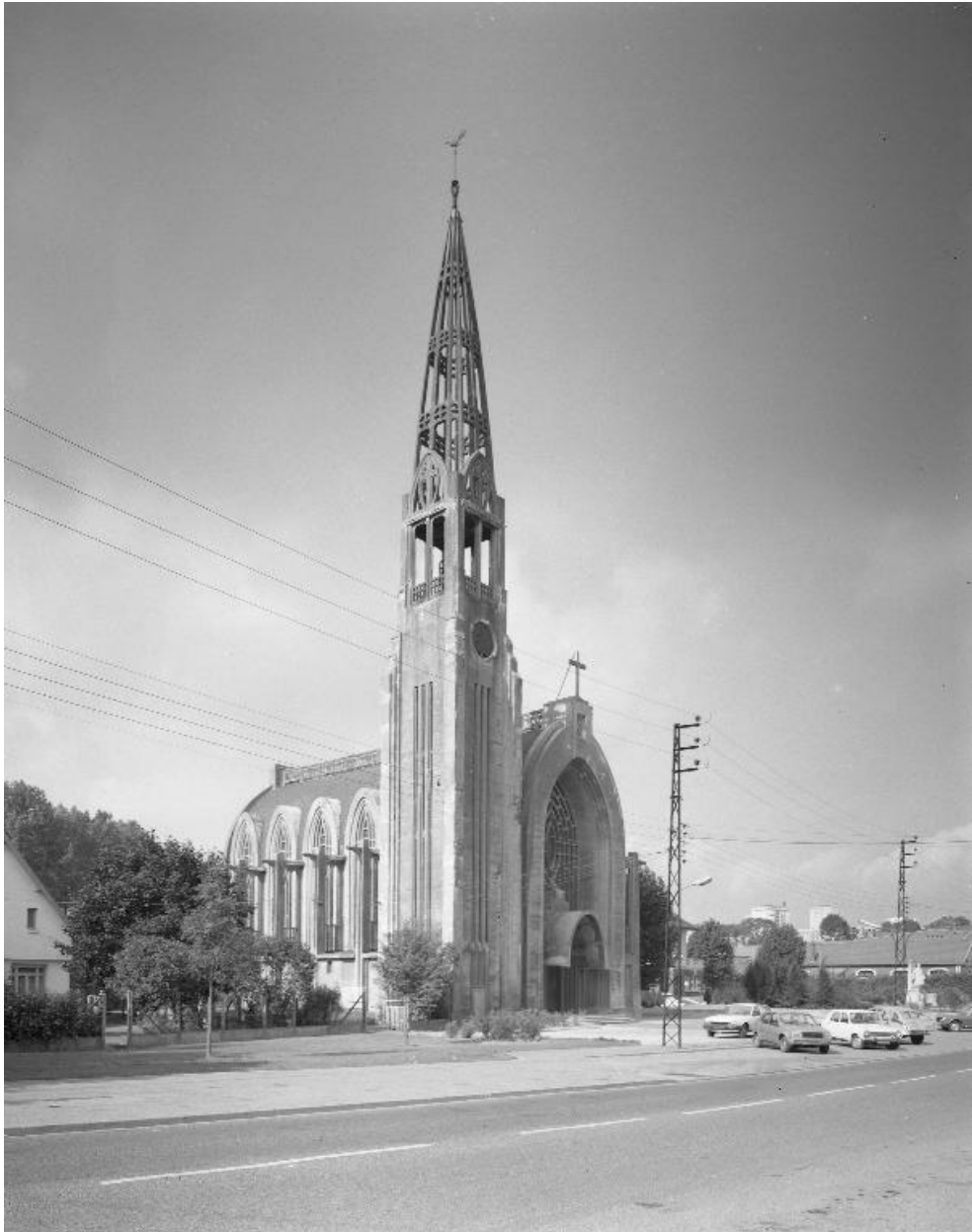
Vue générale prise du Nord Ouest.
