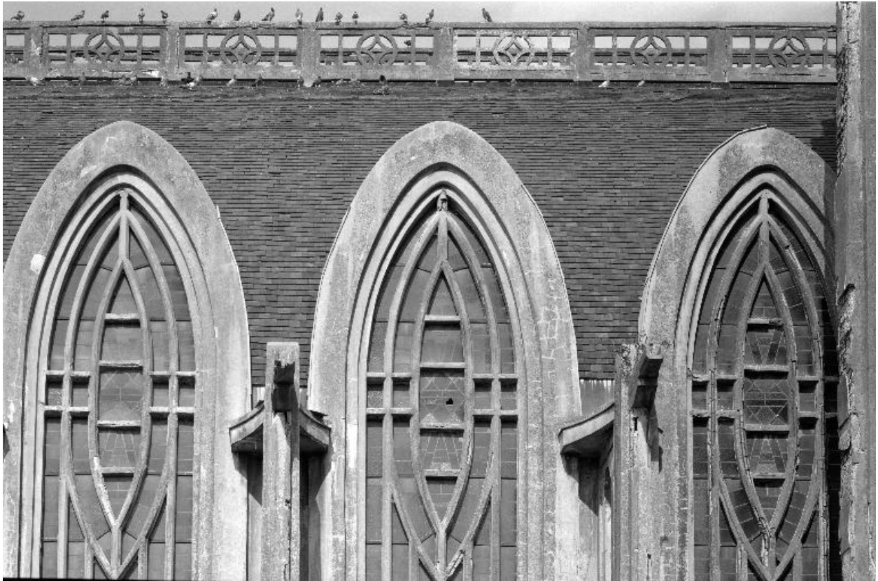
Façade Nord, détail : toiture et lunettes des baies.
