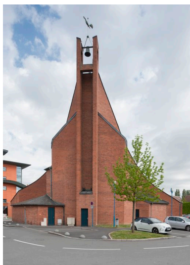
Façade postérieure. Vue générale. Phot. Hubert Bouvet IVR31_20156200165NUCA
