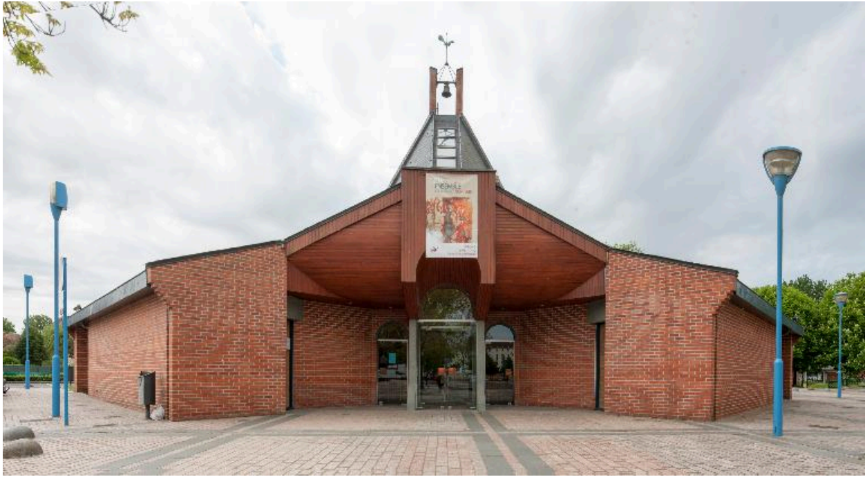
Façade antérieure. Vue générale prise du nord est.
