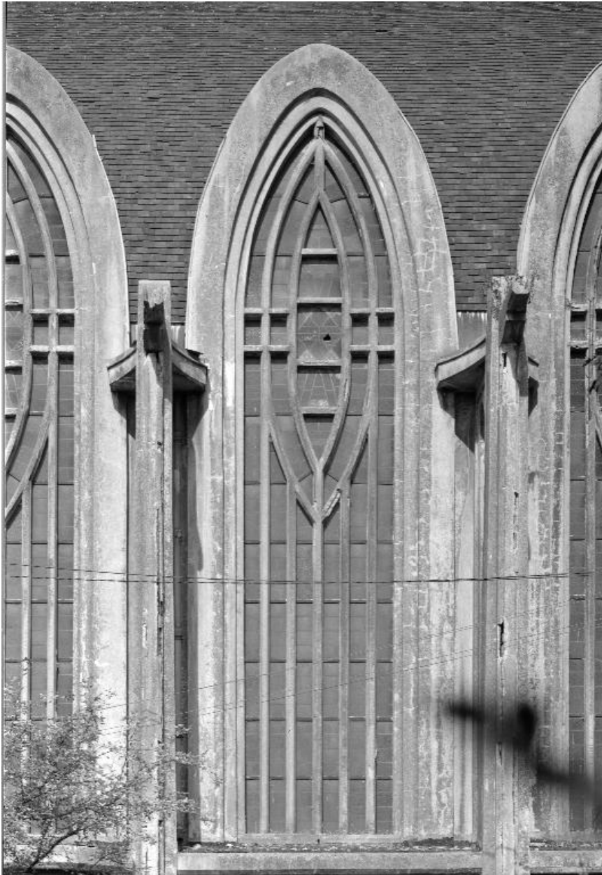
Façade Nord, détail : fenêtres.
