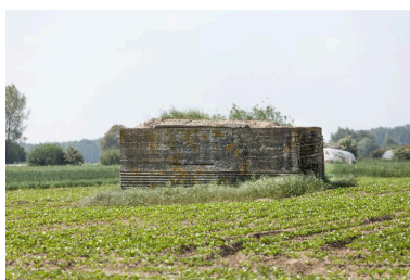
Vue vers le sud-ouest Phot. Jean-Marc Ramette IVR31_20145905448NUCA
