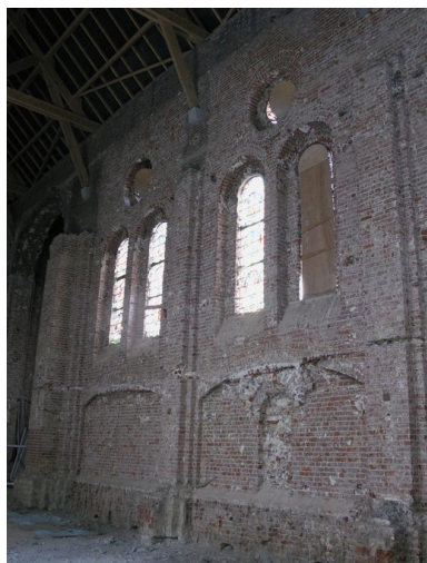
Mur sud de la nef
