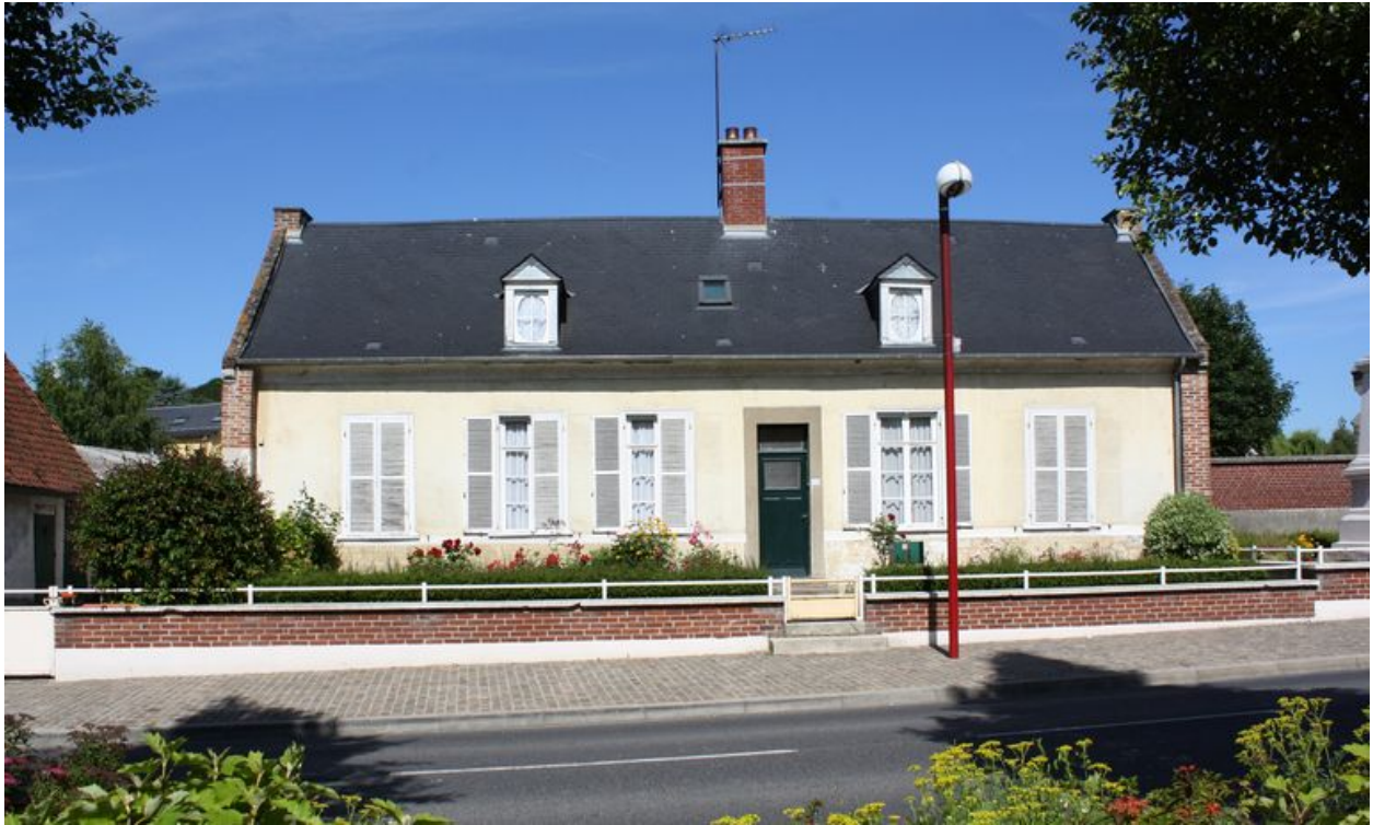
Vue générale, façade sur rue.
