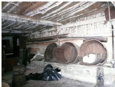
Vue intérieure de la partie étable située dans la grange. Phot. Inès Guérin IVR22_20078005687NUCA
