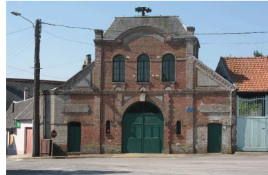
Vue générale. Phot. Romain Grimaud IVR22_20128005259NUC2A
