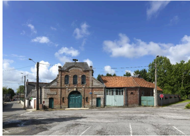
Vue d'ensemble. Phot. Thierry Lefébure IVR22_20158000486NUC2A
