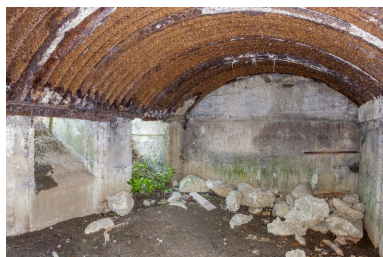
Vue intérieure vers le sud-ouest Phot. Pierre Thibaut
