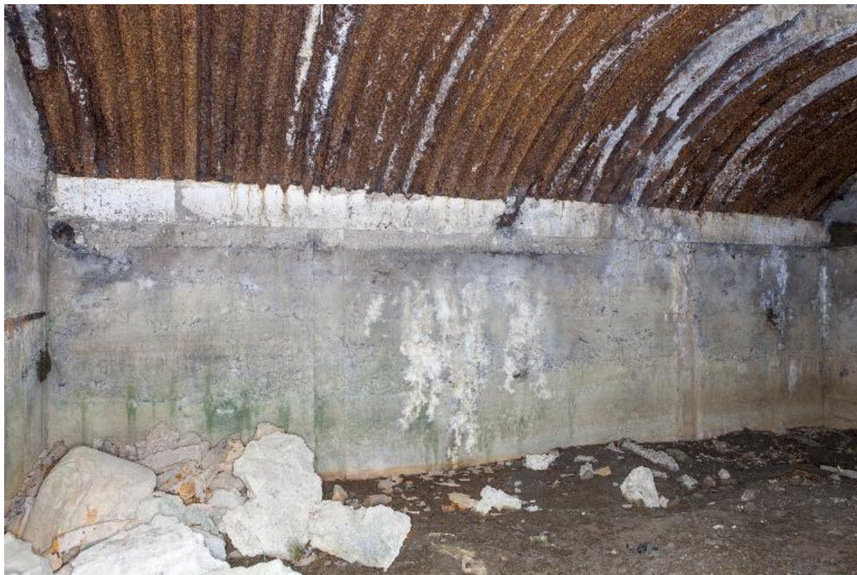
Vue intérieure, mur nord-ouest
