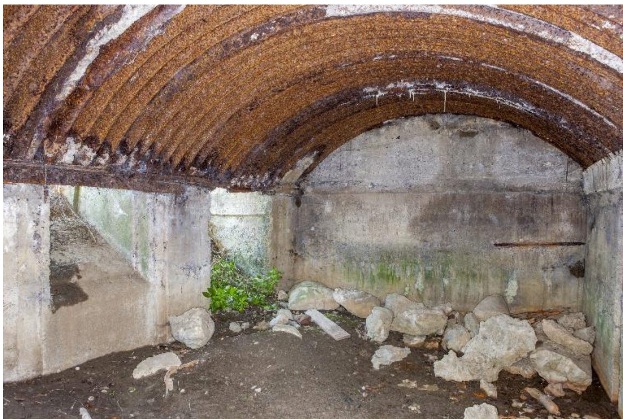
Vue intérieure vers le sud-ouest
