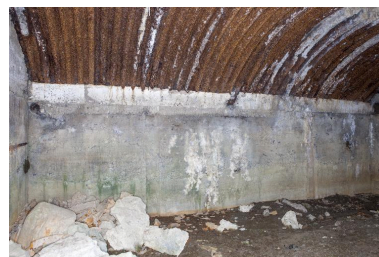
Vue intérieure, mur nord-ouest Phot. Pierre Thibaut
