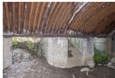
Vue intérieure vers les deux entrées encadrant un dispositif probablement destiné à escamoter rapidement la ou les mitrailleuse(s) Phot. Pierre Thibaut IVR31_20155901711NUCA
