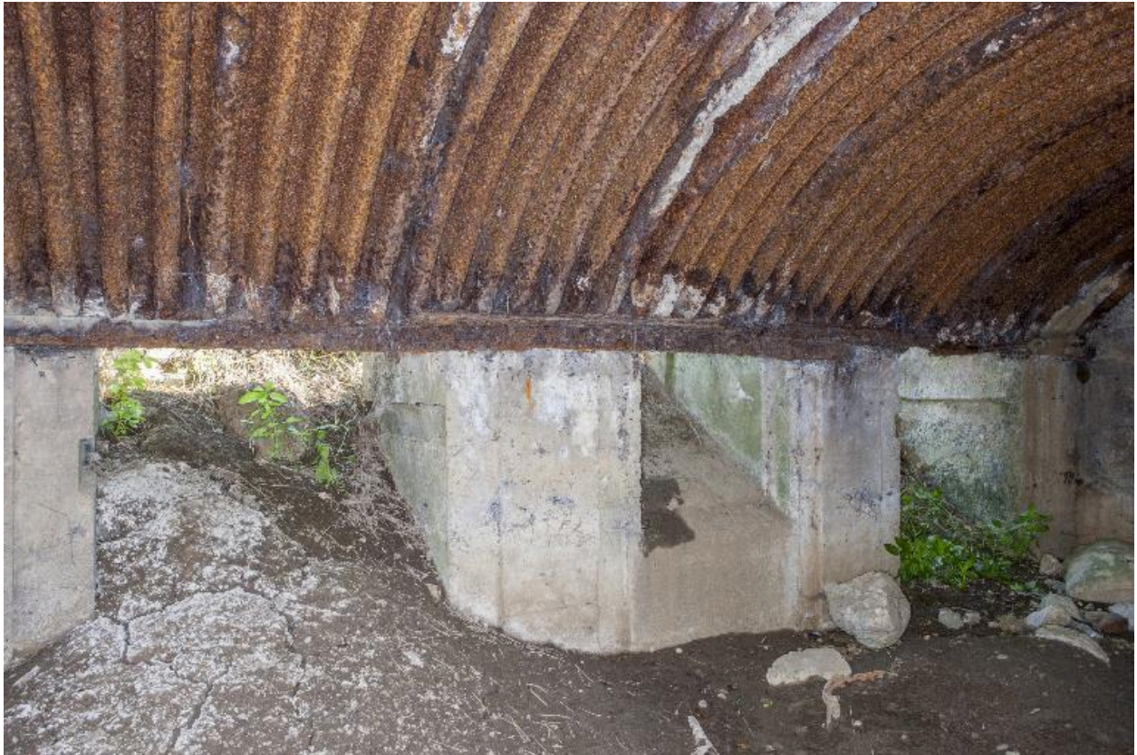
Vue intérieure vers les deux entrées encadrant un dispositif probablement destiné à escamoter rapidement la ou les mitrailleuse(s)
