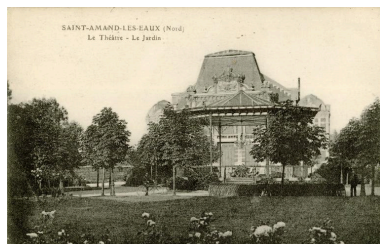
SAINT-AMAND-LES-EAUX (Nord) Le Théâtre - Le Jardin Le jardin, le kiosque (aujourd'hui disparu) et le théâtre, carte postale sans date (Médiathèque de Saint-amand-les-Eaux). IVR31_20135908034NUCA
