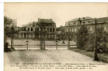
Grilles de l'accès au jardin depuis la Grand'Place, carte postale sans date (Médiathèque Saint-Amand-les-Eaux). IVR31_20125908040NUCA
