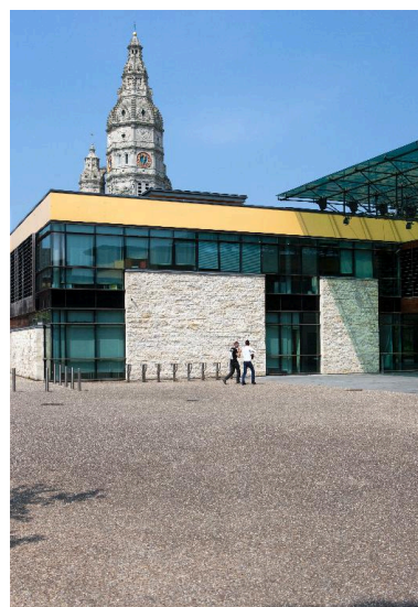
Vue de la médiathèque et la tour abbatiale à l'arrière plan. Phot. Pierre Thibaut IVR31_20125901731NUCA
