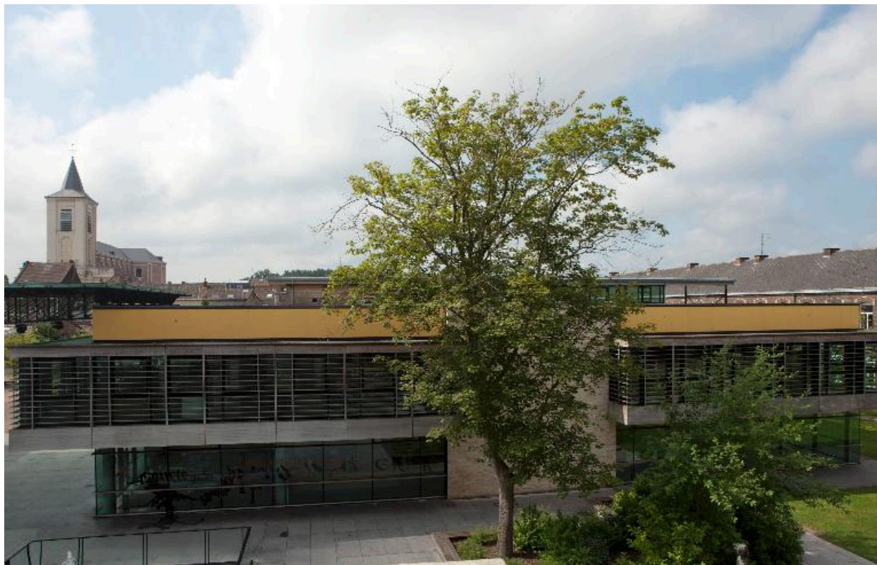
Vue vers la médiathèque, construite en (2010 ?) et attenante au théâtre, l'église paroissiale au second plan.
