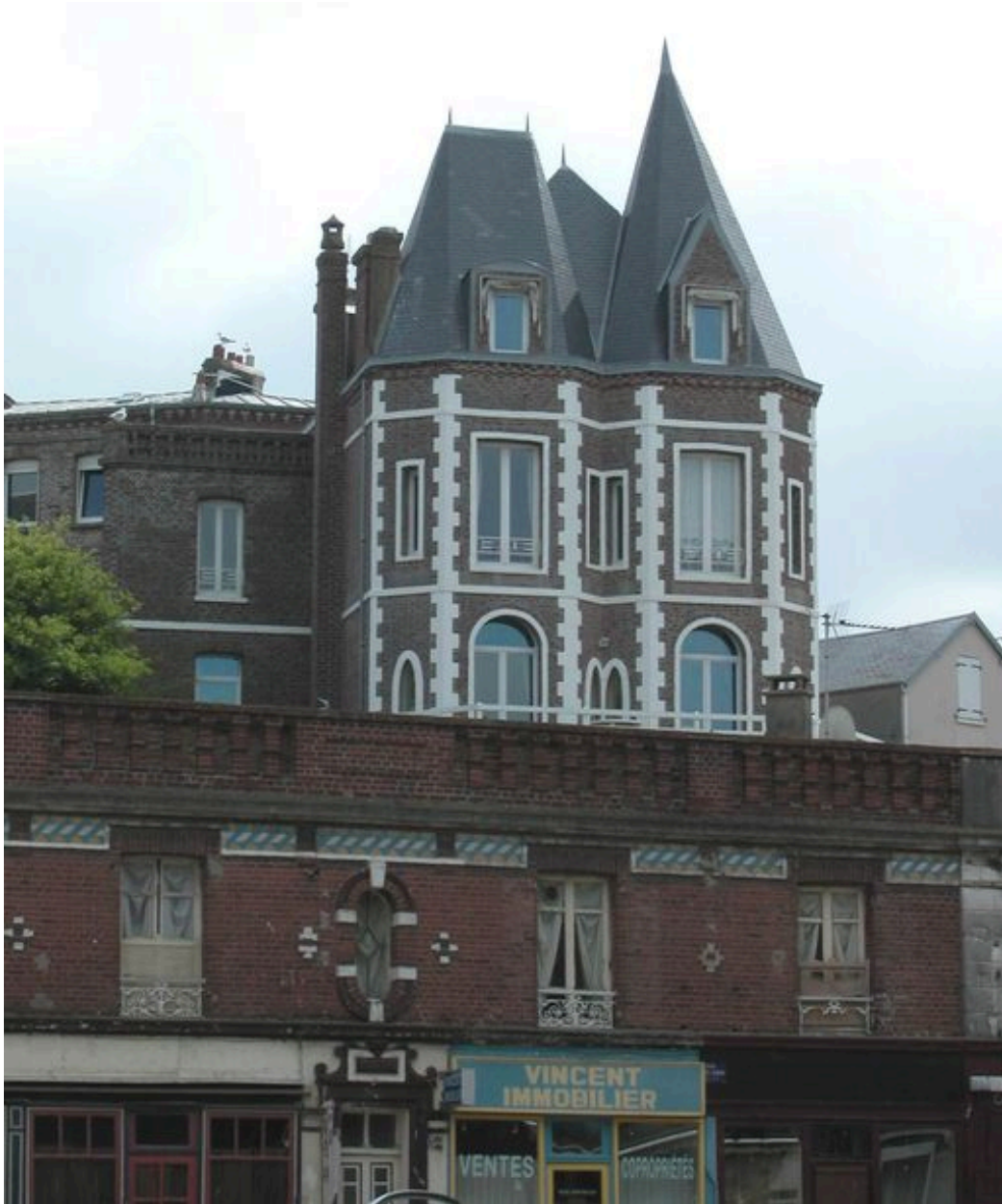
Vue d'ensemble depuis la rue Raspail.
