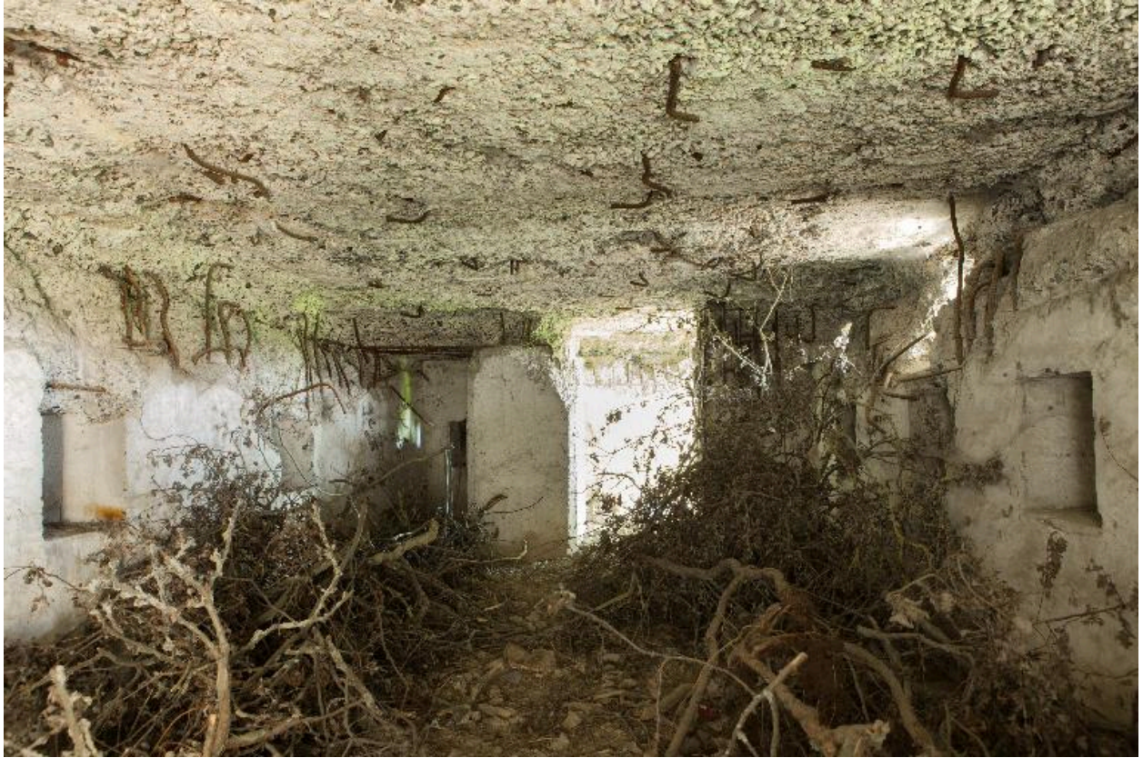
Vue intérieure, vers l'est
