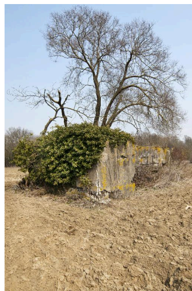
Vue générale vers le nord-est Phot. Jean-Marc Ramette IVR31_20145904042NUCA
