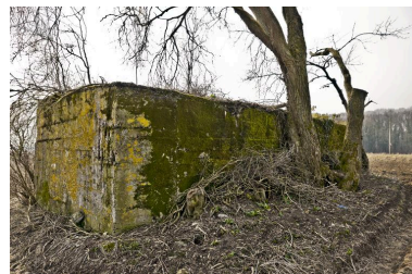
Vue de trois-quarts arrière, vers sud-ouest Phot. Jean-Marc Ramette IVR31_20145904032NUCA
