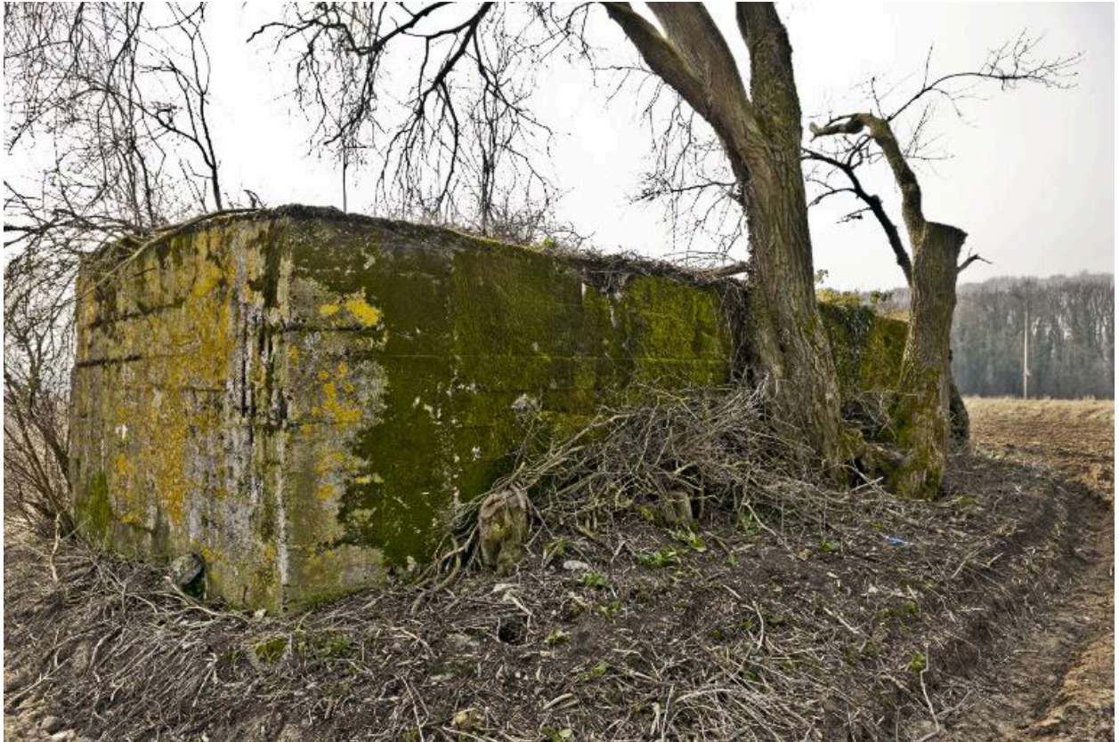
Vue de trois-quarts arrière, vers sud-ouest
