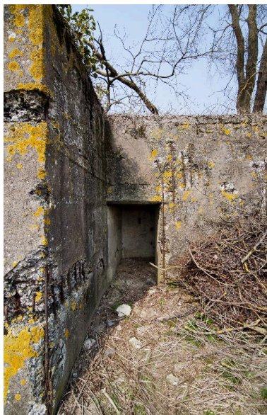
Entrée ouest Phot. Jean-Marc Ramette IVR31_20145904041NUCA
