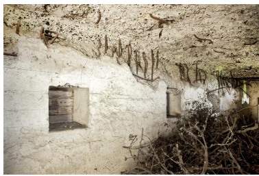
Vue intérieure, niches à munitions Phot. Jean-Marc Ramette IVR31_20145904037NUCA
