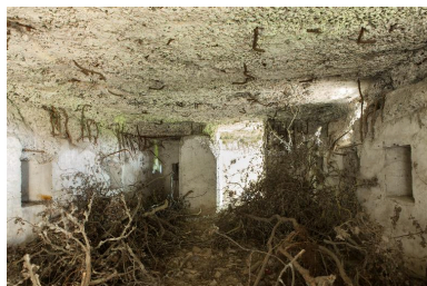
Vue intérieure, vers l'est Phot. Jean-Marc Ramette IVR31_20145904040NUCA
