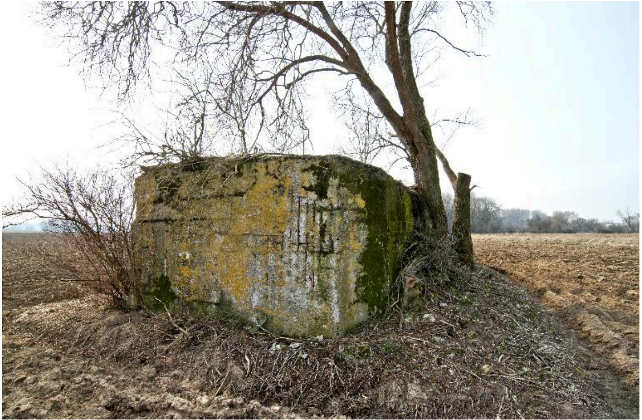
Vue de trois-quarts arrière, vers sud-ouest
