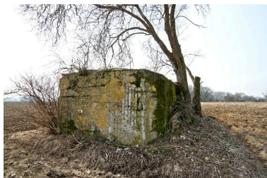
Vue de trois-quarts arrière, vers sud-ouest Phot. Jean-Marc Ramette IVR31_20145904034NUCA
