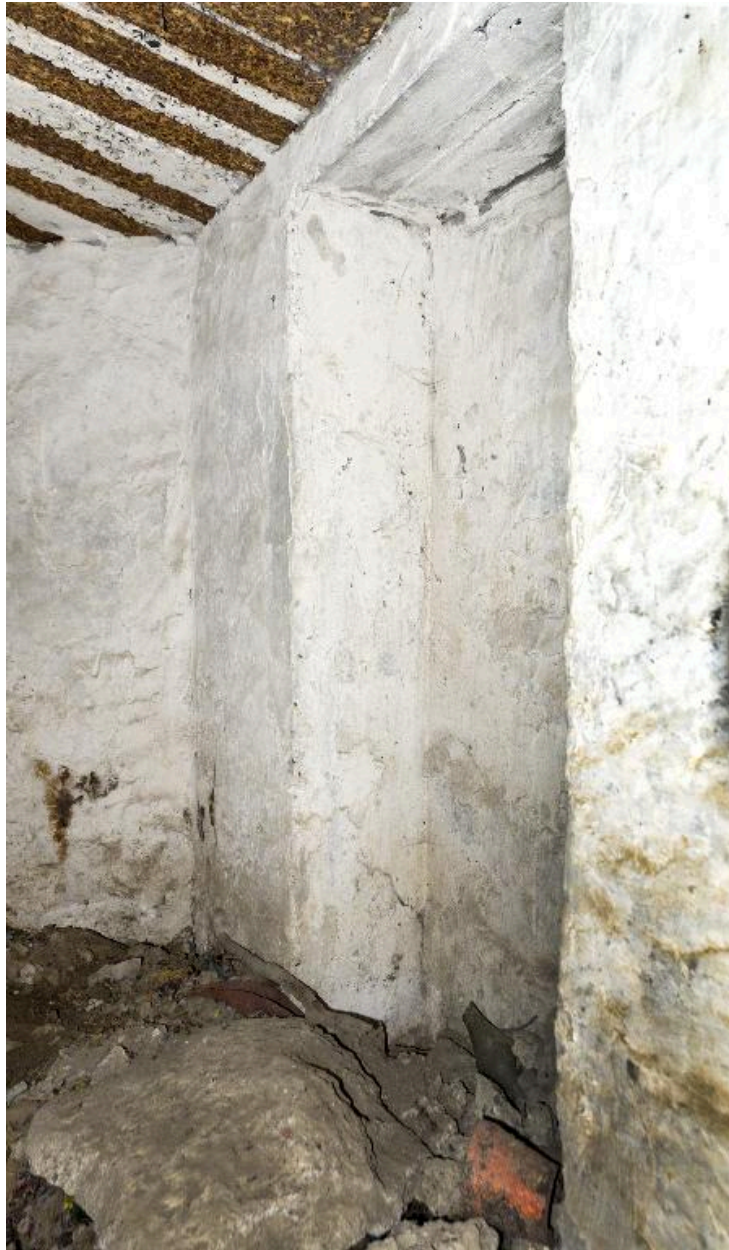
Entrée de la coursière de tir, niche à fusils
