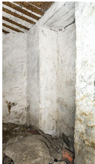
Entrée de la coursière de tir, niche à fusils Phot. Jean-Marc Ramette IVR32_20175900010NUCA
