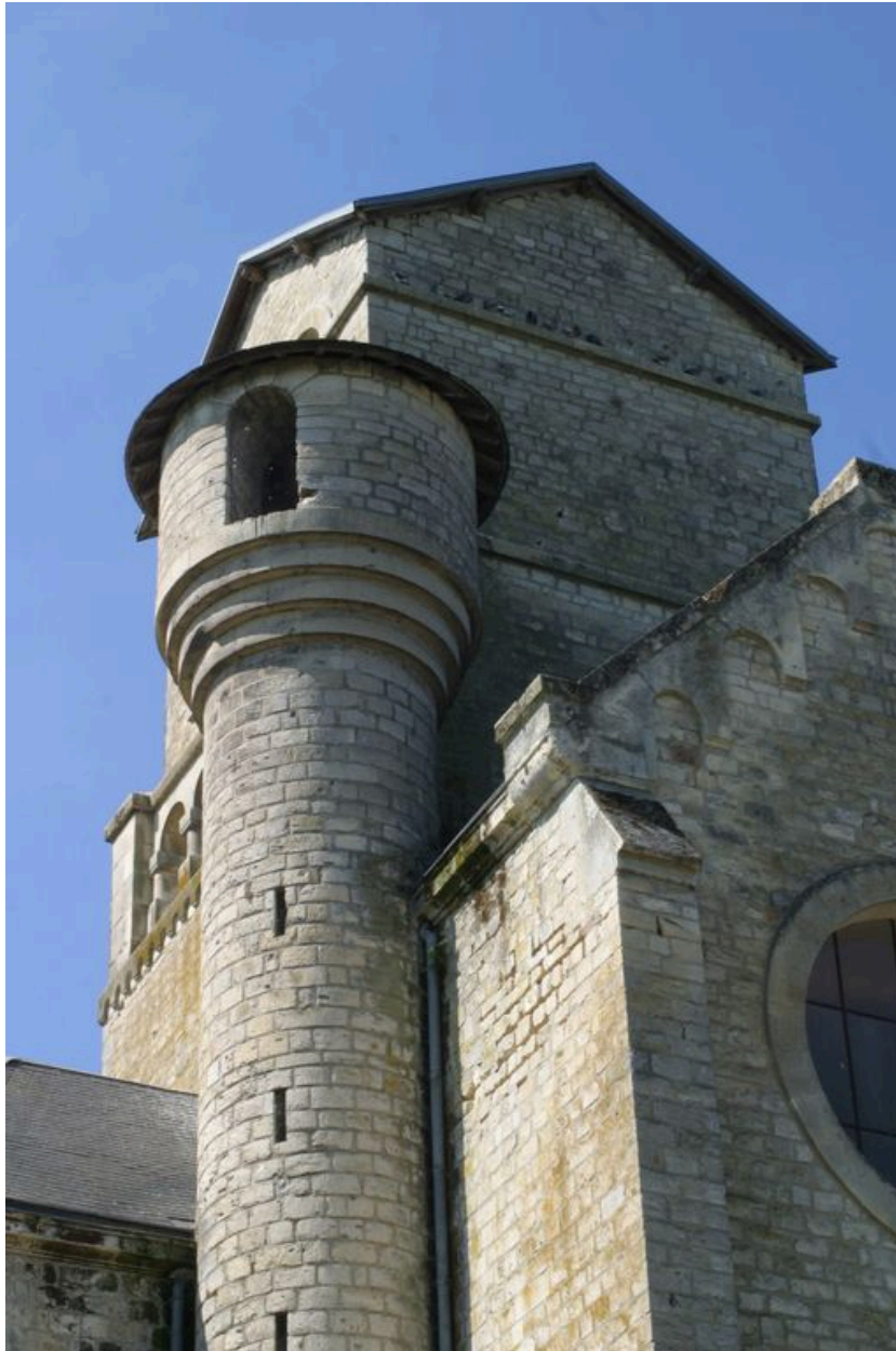
Vue de la tour adossée au clocher.
