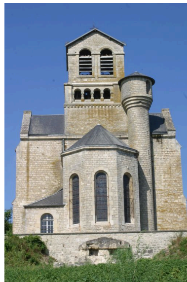
Vue du chevet. Phot. Inès Guérin IVR22_20030202687NUCA
