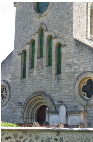
Vue partielle de la façade. Phot. Inès Guérin IVR22_20030202688NUCA
