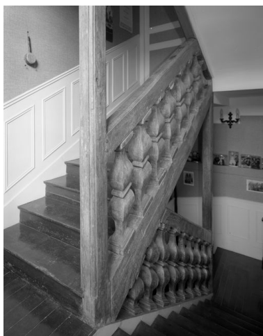
Cage d'escalier. Phot. Fabrice Charrondièrre IVR22_19856001517V
