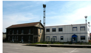
Les bureaux de l'usine. Phot. Clarisse Lorieux IVR22_20076005274NUCA
