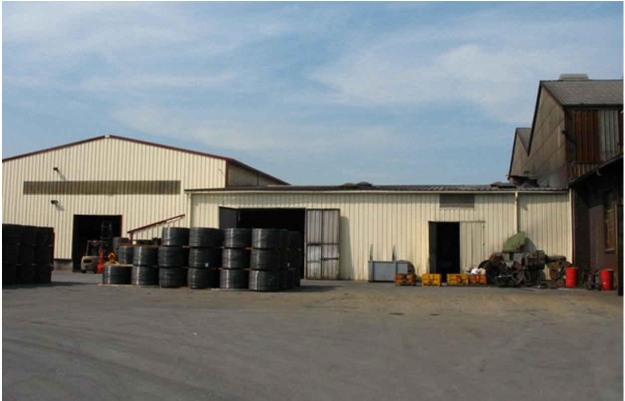
Les bâtiments de la tréfilerie.
