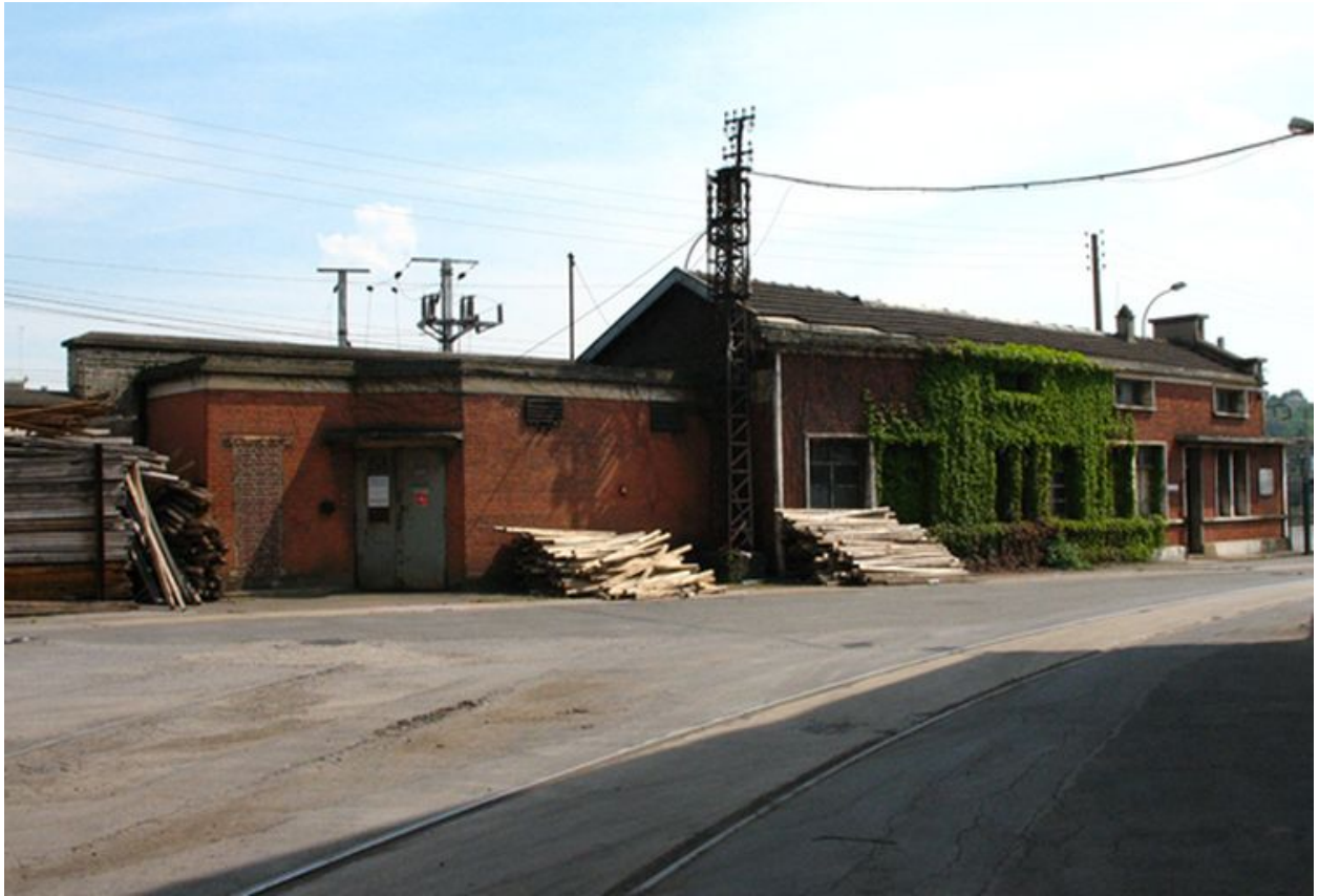
Transformateur électrique et bâtiment de la pointeuse.
