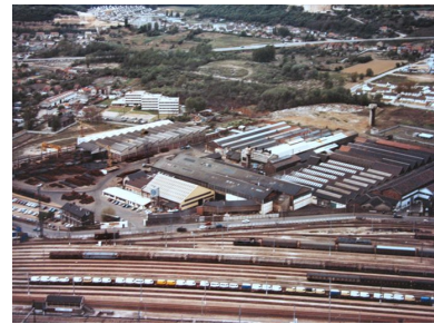
Vue aérienne de l'usine Acor au milieu des années 1980 (AP). Phot. Clarisse Lorieux IVR22_20066005199NUCAB
