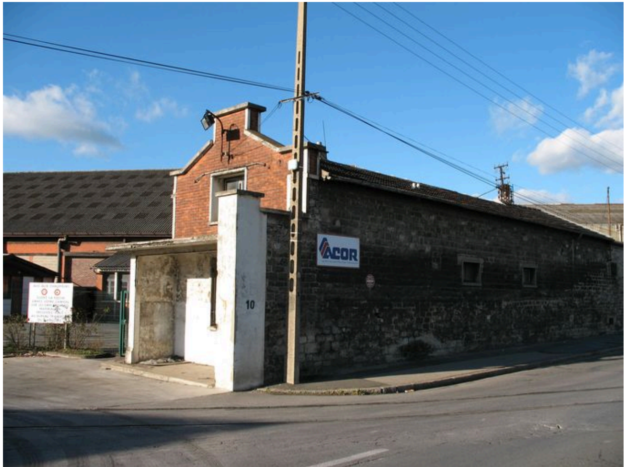
Le bâtiment de la pointeuse depuis la rue des Usines.
