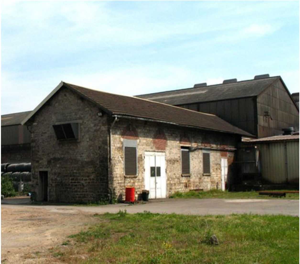
Atelier de fabrication ayant abrité des fours.
