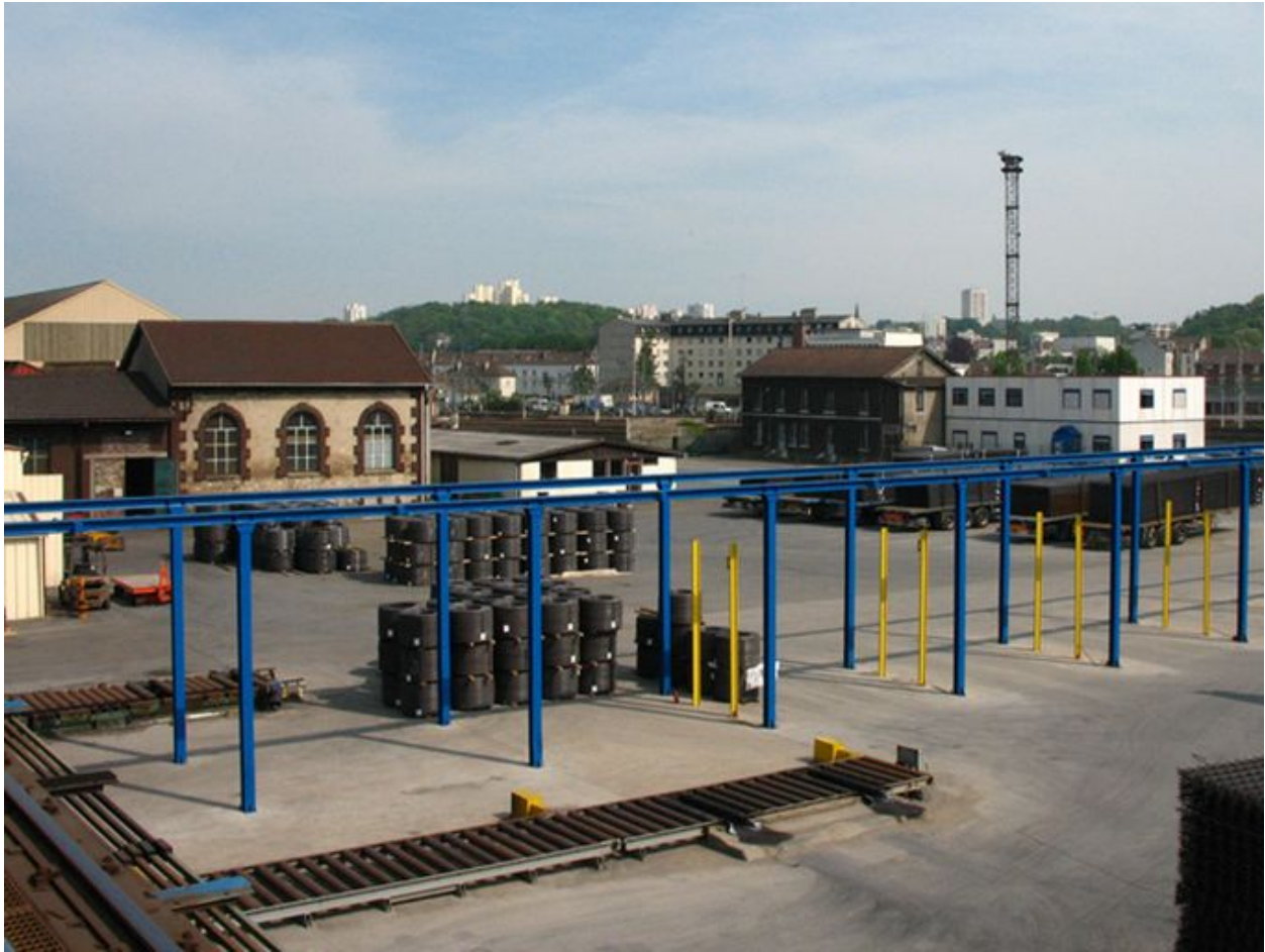
Tapis roulant sortant des ateliers de fabrication de treillis-soudés.
