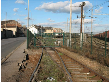
Liaison de la desserte interne aux lignes ferrées. Phot. Clarisse Lorieux IVR22_20066005200NUCA
