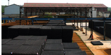
Vue depuis le pont-roulant des aires de stockage des treillis-soudés. Phot. Clarisse Lorieux IVR22_20076005276NUCA
