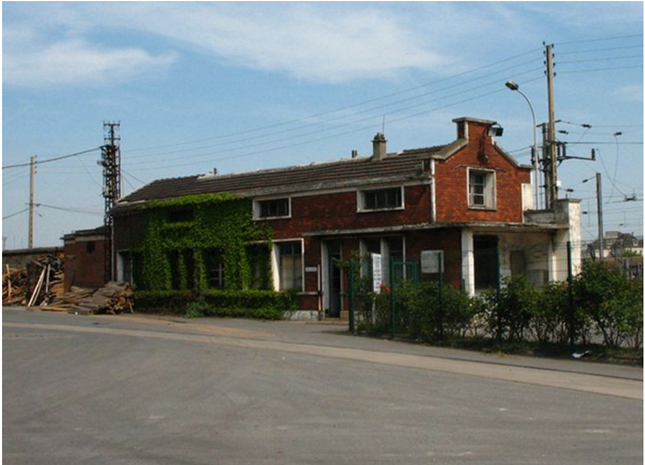
Le bâtiment de la pointeuse à l'entrée de l'usine.
