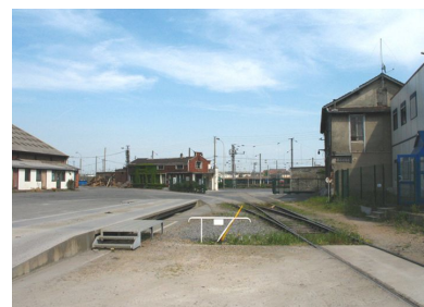
Embranchement ferroviaire et quai de déchargement. Phot. Clarisse Lorieux IVR22_20076005262NUCA
