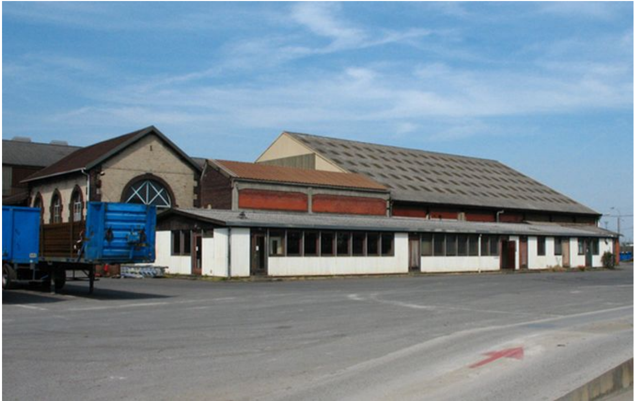
Les bâtiments de stockage et au premier plan les vestiaires.
