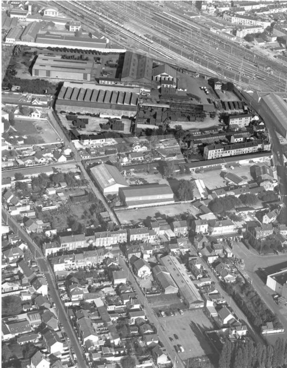
Vue aérienne de l'usine ACOR et de sa cité ouvrière.
