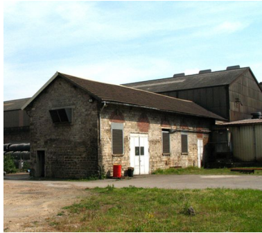
Atelier de fabrication ayant abrité des fours. Phot. Clarisse Lorieux IVR22_20076005269NUCA
