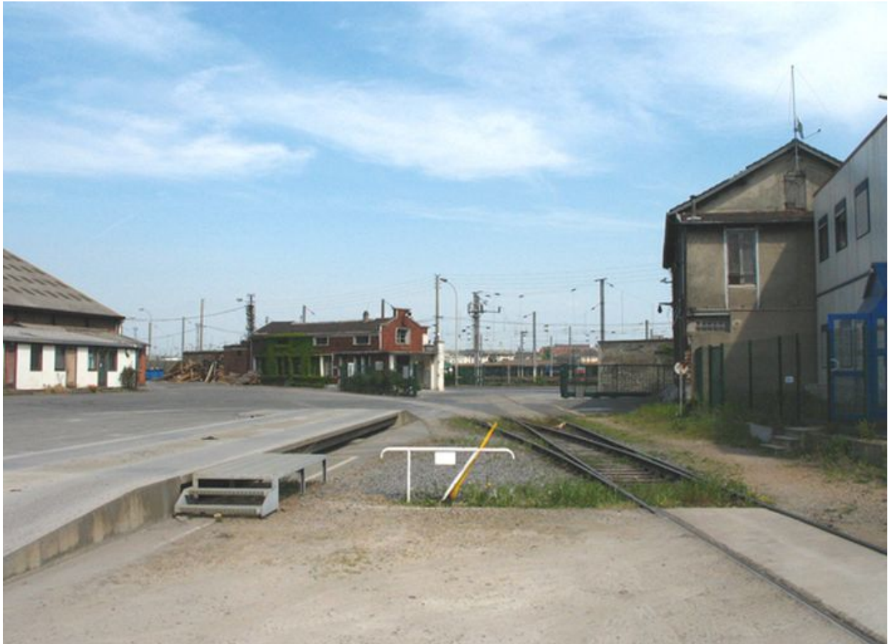
Embranchement ferroviaire et quai de déchargement.
