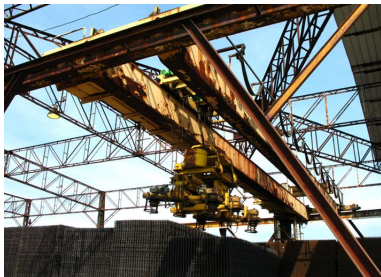
Le spirgrip agrippe les plaques de treillis-soudés pour les chargements. Phot. Clarisse Lorieux IVR22_20076005275NUCA
