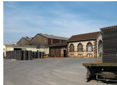
Les bâtiments de stockage des bobines et le laboratoire contrôle qualité. Phot. Clarisse Lorieux IVR22_20076005277NUCA
